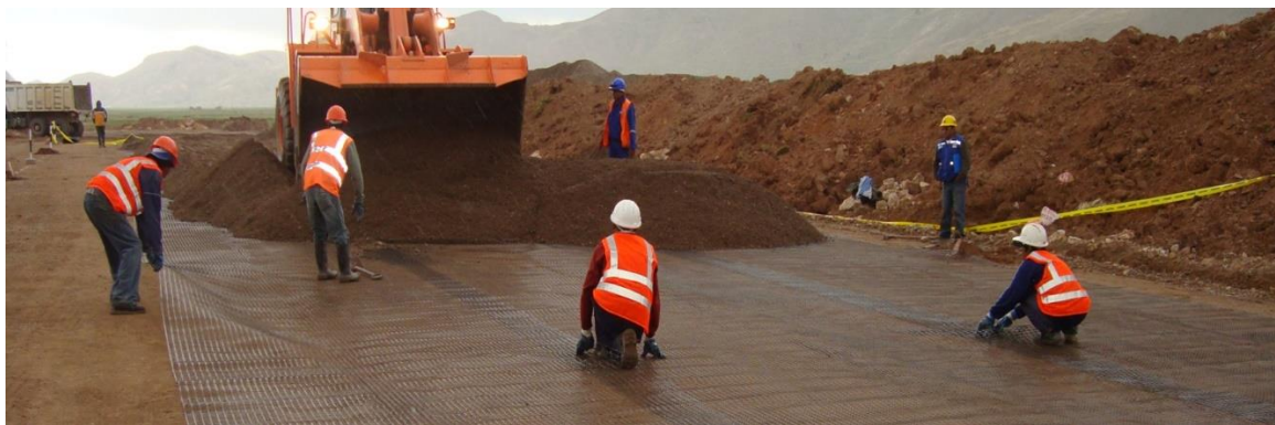
Estabilización de suelos
