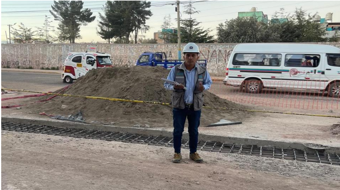
Fotografía 6. Obra de mejoramiento de transitabilidad vehicular
