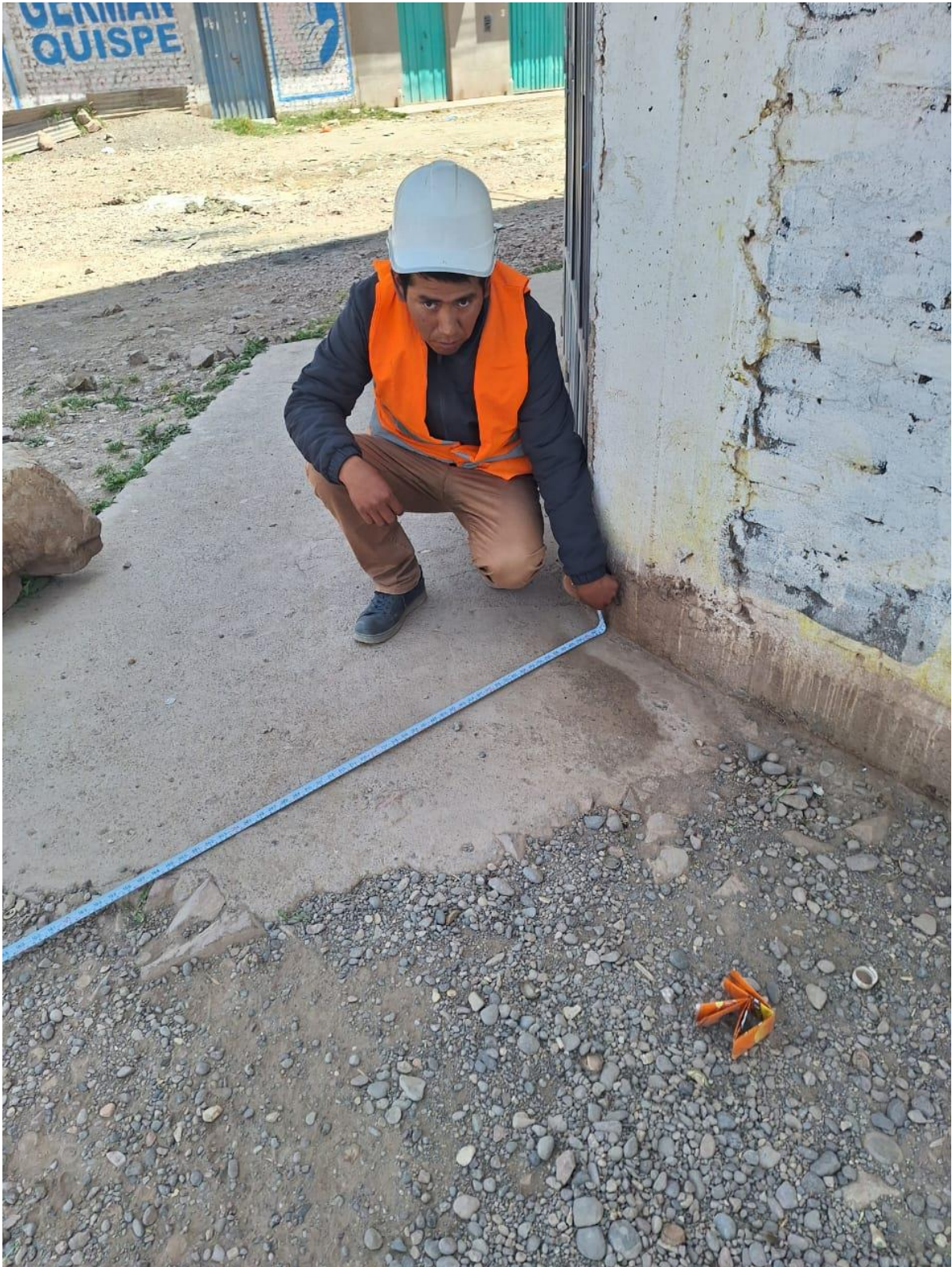
Fotografía 2 Predimensionamiento de calzada, cuneta y rampas.
