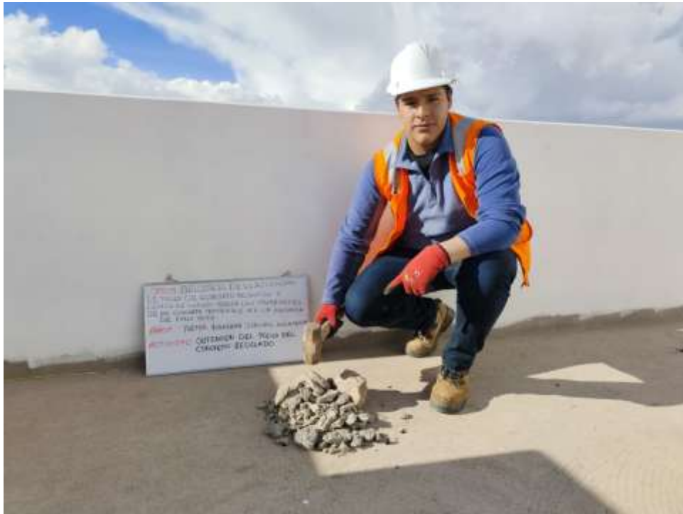
Fotografía 1. Presentación de recolección de concreto reciclado.
