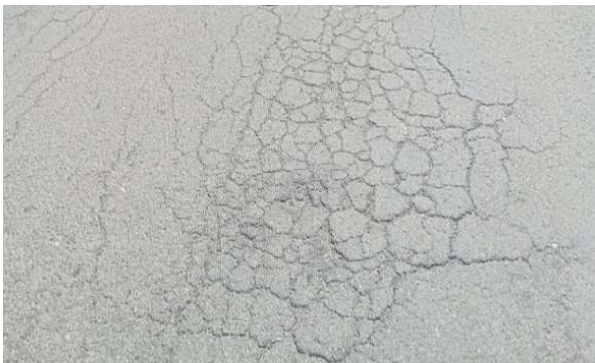
Fotografía 5. Falla Piel de cocodrilo – Salida a Caminaca
