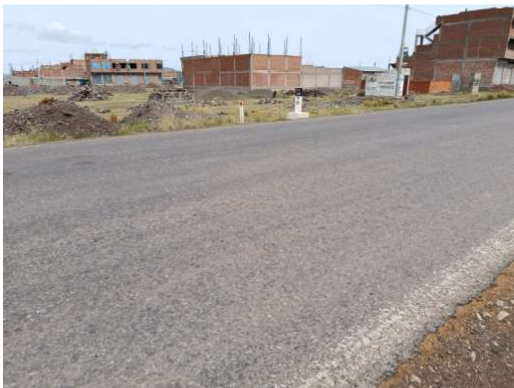
Fotografía 9. Pulvimientos de agregados - Salida a Caminaca
