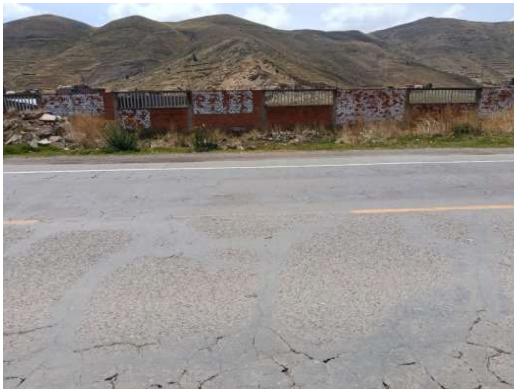
Fotografía 4. Parcheos y fisuras – Salida Arequipa
