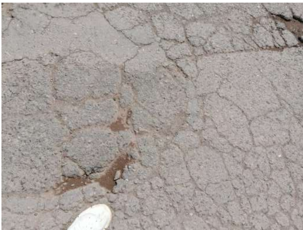
Fotografía 3. Piel de cocodrilo, severidad alta – Salida Arequipa
