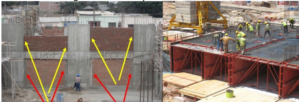
Figura 144 Colocación con agua de concreto prefabricado
