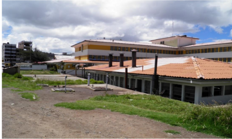
FOTOGRAFÍA 3: Reservorio de base y casa de motor
