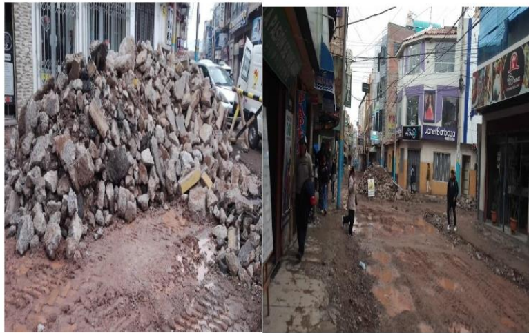
Foto N° 11: vista de acumulación de concreto reciclado.
