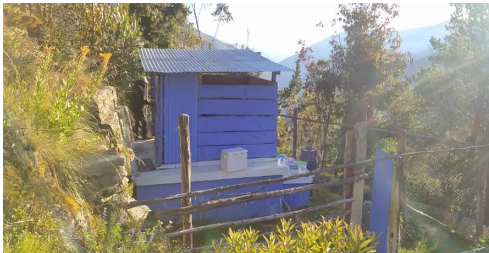
Fotografía 2. Sistema de distribución (reservorio) de agua para consumo humano Cuyocuyo.
