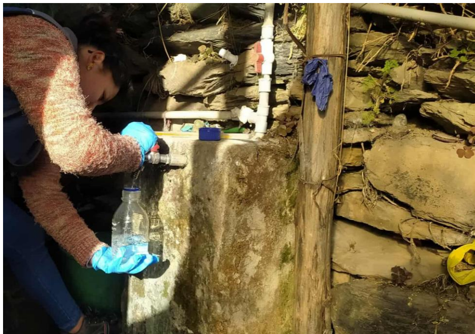
Fotografía 6. Toma de muestras de la red de distribución de agua potable del distrito de Cuyocuyo
