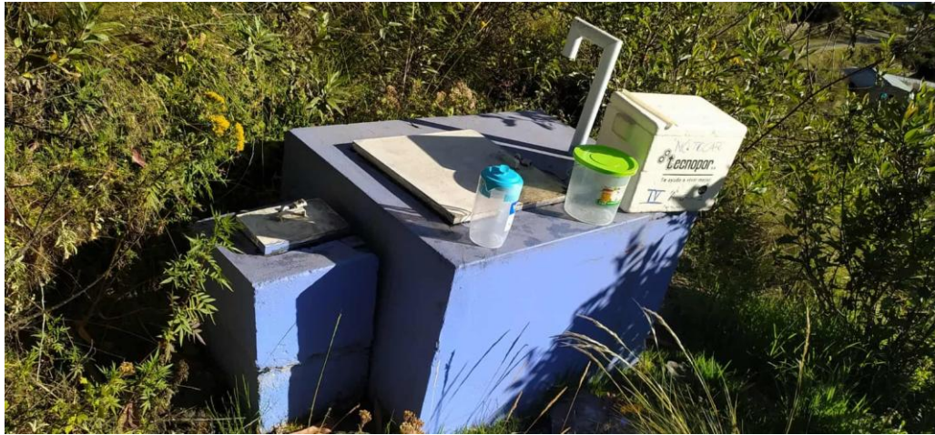
Fotografía 1. Sistema de captación de agua para consumo humano Cuyocuyo.
