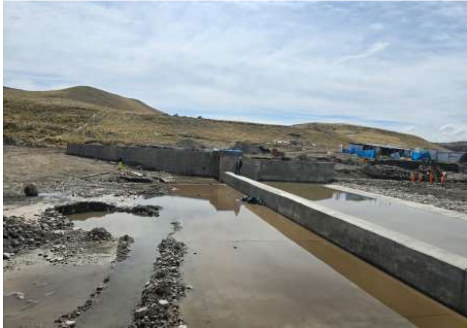
Curado del solado Zampeado aguas arriba F'c=140 \text{ kg/cm}^2 + 30\%PG de ancho 6mts.
