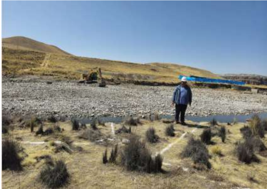
Trazo y replanteo de la bocatoma margen derecha río Sañu
