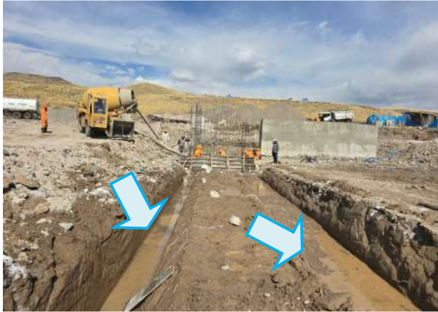
Excavación para dentellones del azud (perfil cimaceo).
