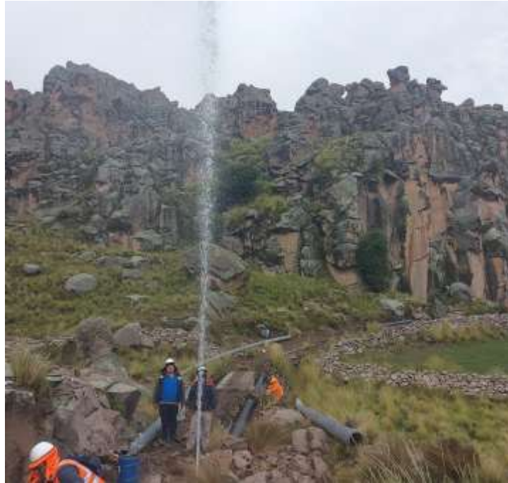
Prueba hidráulica en la línea de conducción. Progresiva 0+150, 0+450
