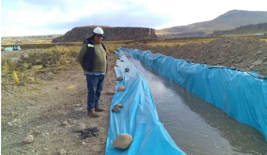
Desvío de río Sañumayo mediante una canal provisional de longitud 310m.
