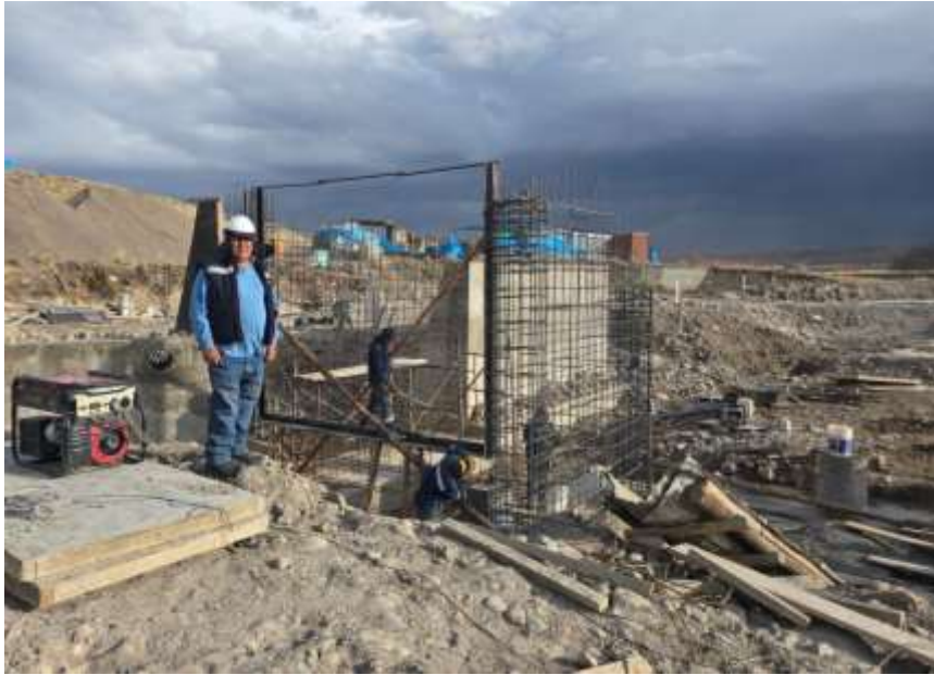
Colocado del marco de compuerta del canal de limpia, del baraje móvil.
