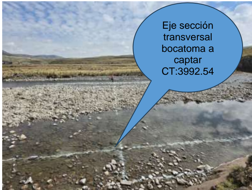
Trazo y replanteo del eje del azud.
