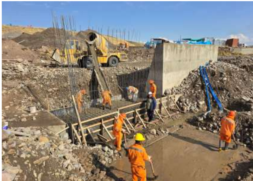
Vaciado de concreto f_c : 210 kg/cm 2 para muro de encauzamiento MI
