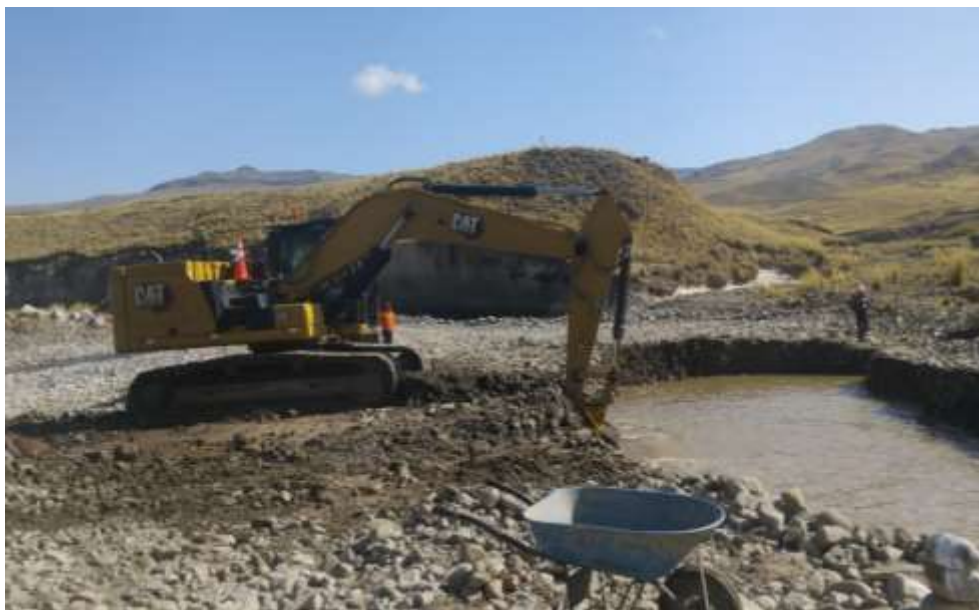
Excavación para la cimentación de muro de encauzamiento, margen izquierdo del río Sañu.
