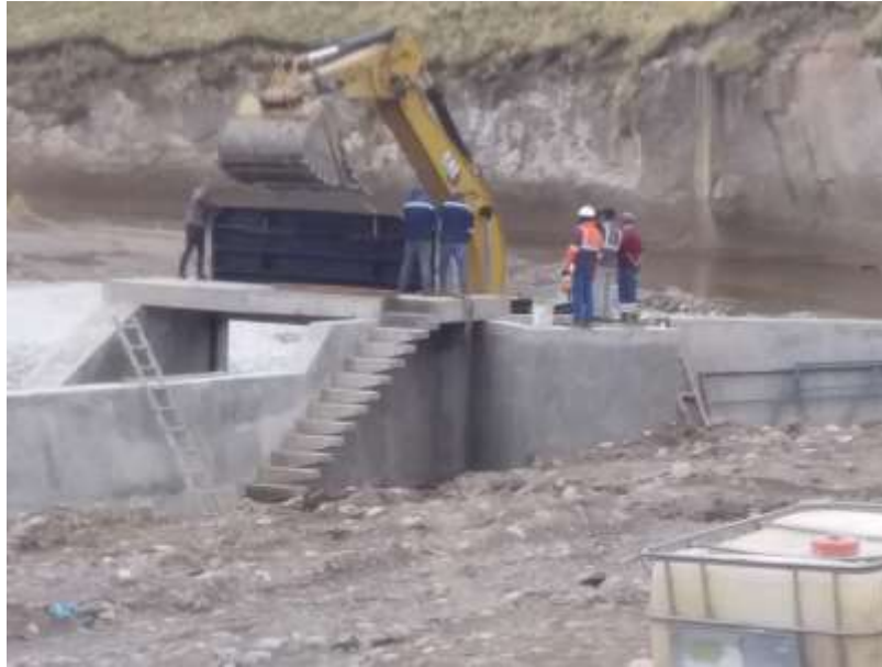
Montaje de compuerta metálica ASTM A36 de 4mts x 1.4mts.
