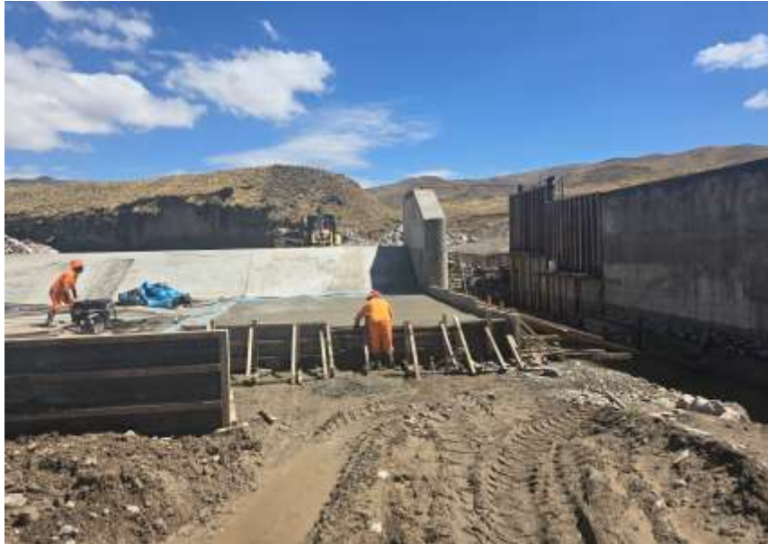
Proceso de vaciado de concreto ciclópeo f_c: 140 \text{ kg/cm}^2 + 30\% \text{PG} en la poza disipadora.
