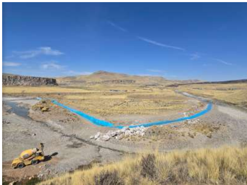
Desvió del cauce del río Sañumayo por margen derecha
