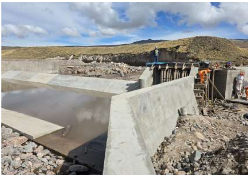
Encofrado de losa de maniobras y escalera de acceso.
