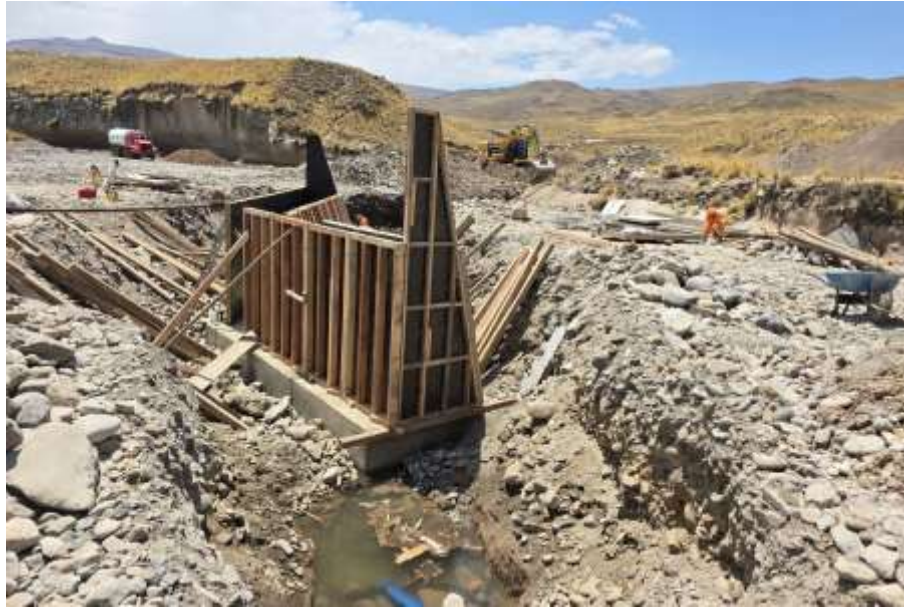
Encofrado del muro de encauzamiento margen izquierdo
