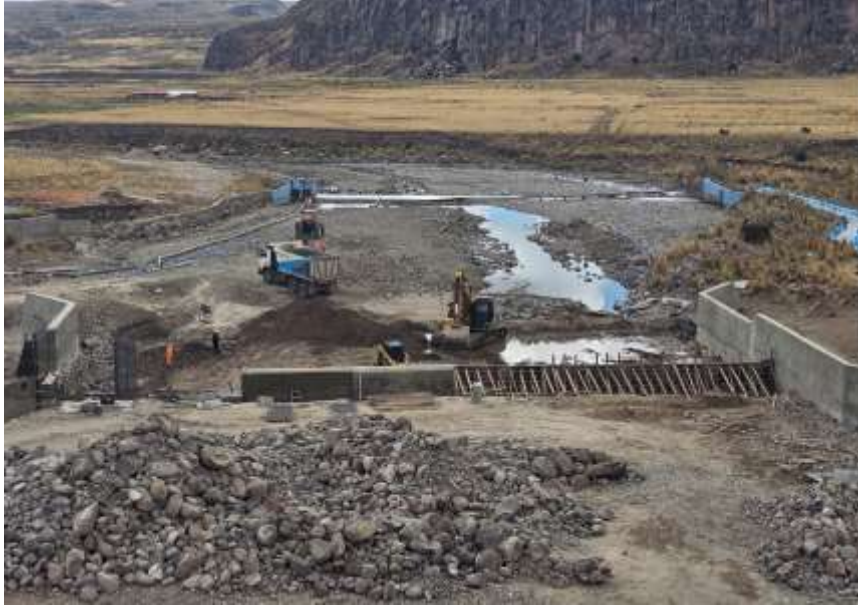
Vista general del proceso constructivo del barrage fijo, tipo creaguer.
