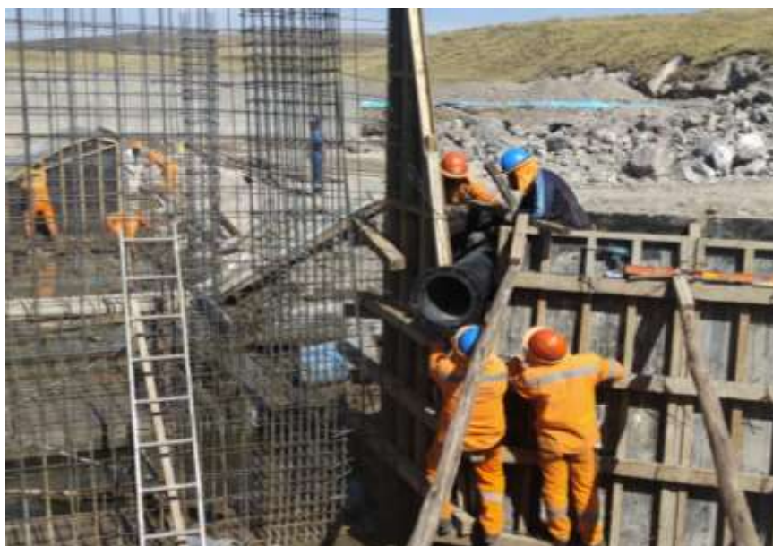
Instalación de tubería de captación de fierro fundido DN 315mm para captar Q diseño: 45lt/s
