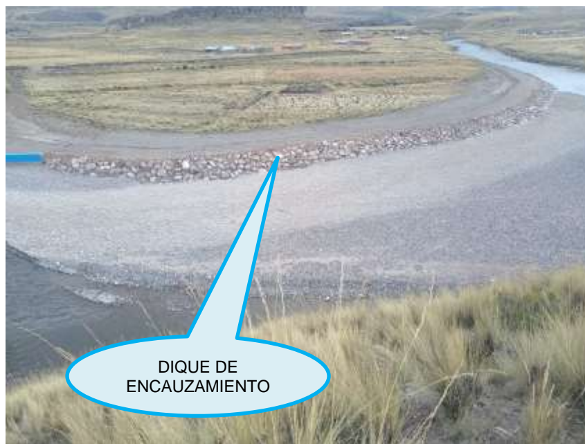
Diques de protección para evitar desbordamiento en la MD de L=180ml
