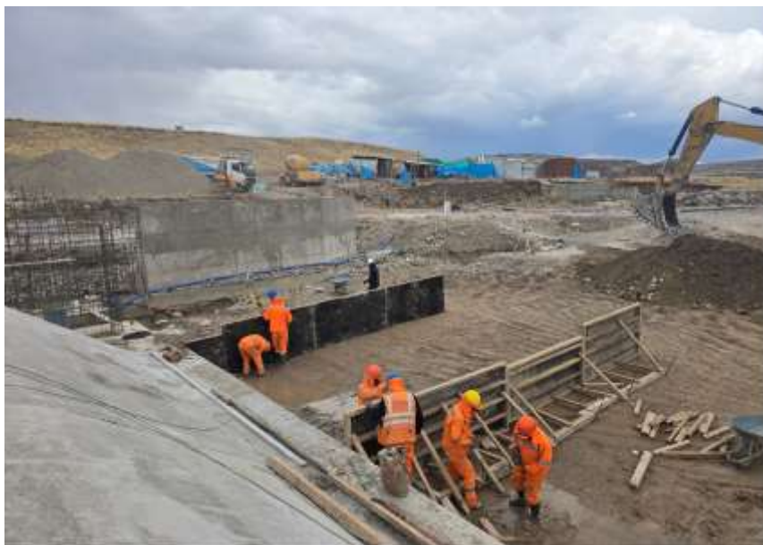
Encofrado de la poza disipadora.
