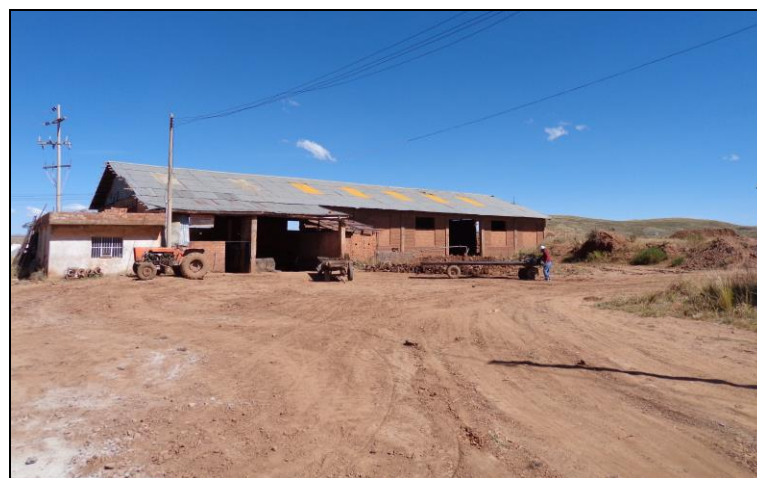
Fotografía 14. Vista panorámica de la planta de producción de la ladrillería Lamax-A.
