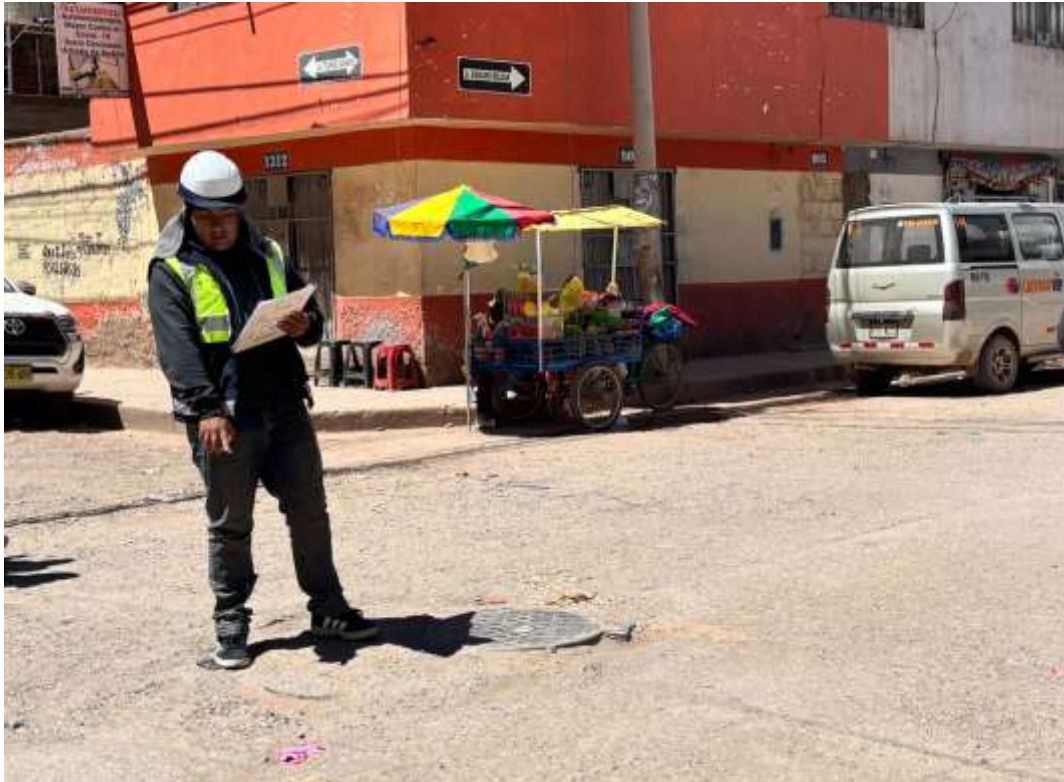
Fotografía 5. Falla de descascaramiento en el Jr. Mariano Melgar
