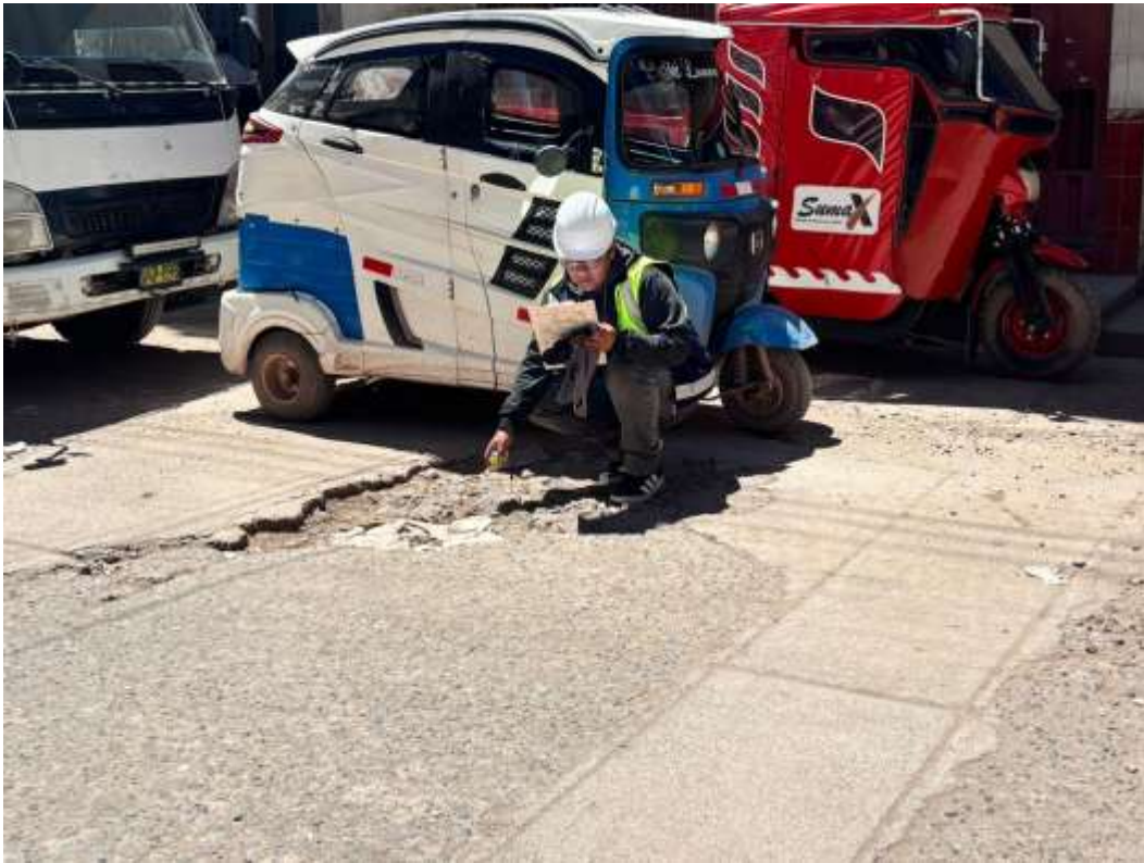
Fotografía 1. Falla "escala" en el Jr. Sucre
