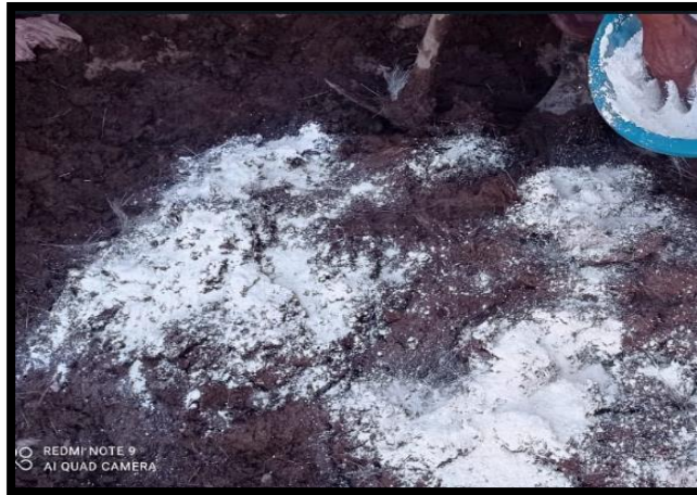
Fotografía 03 : agregando fibras de polipropileno
