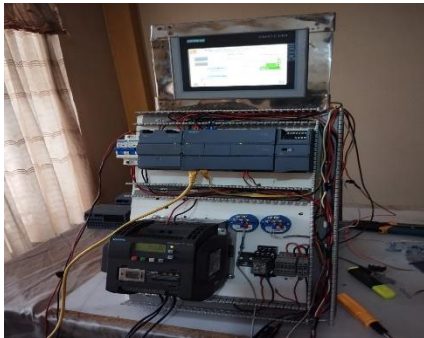
Figura 56 Implementación de Tablero eléctrico y control
