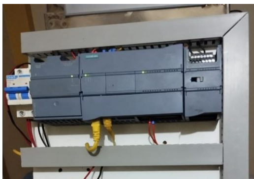
Figura 48 Implantación de sistema de control PLC S71200.
