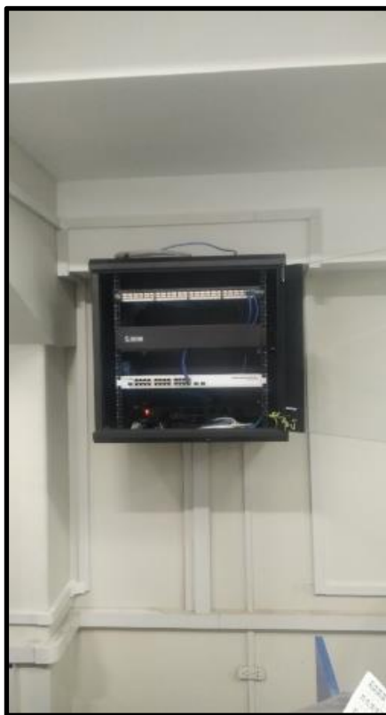
figura 4.19: Instalación de gabinetes de 12RU zona B
