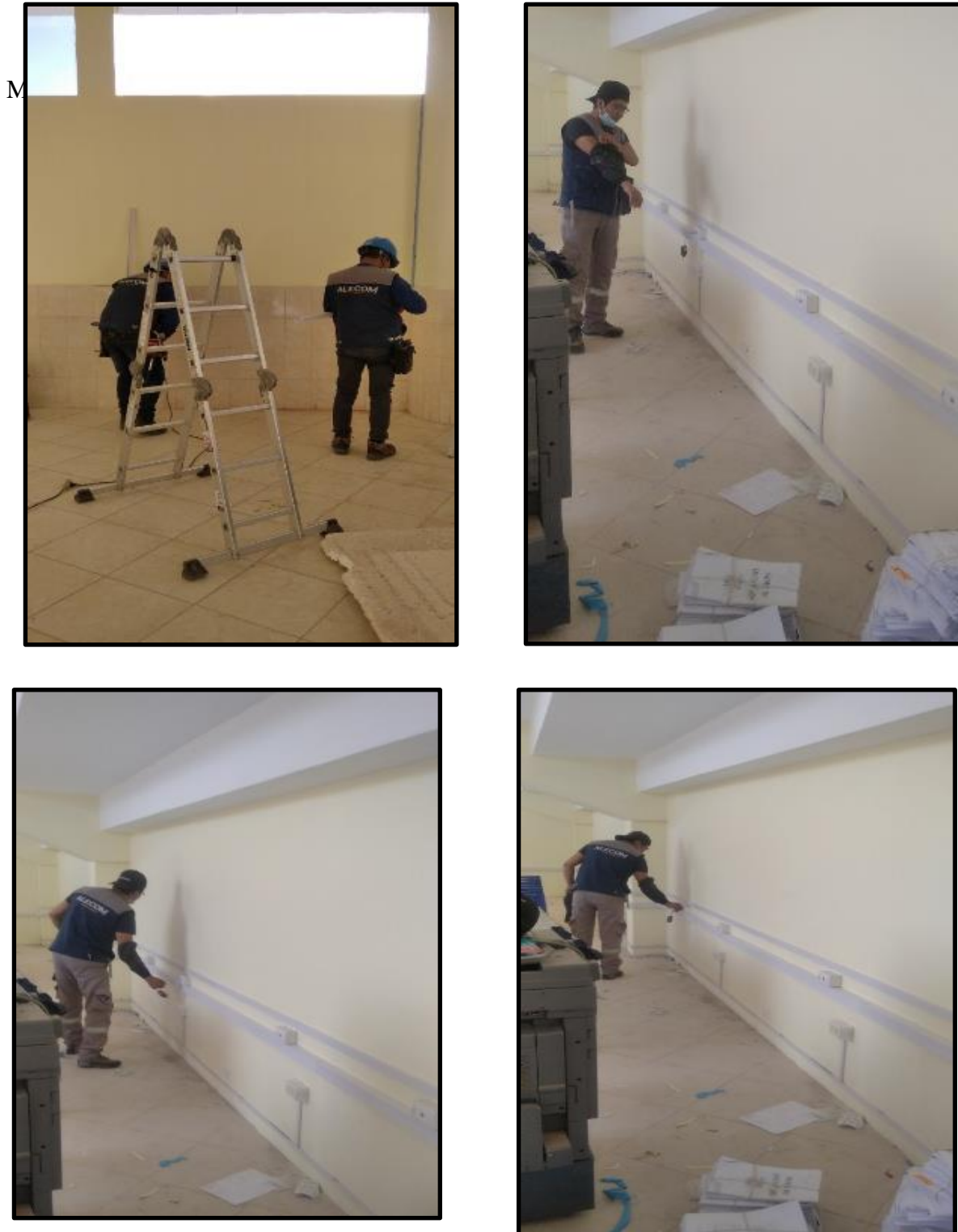
Figura 4.2: instalación canaleteo de oficinas
