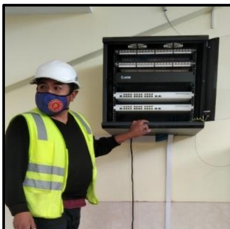
figura 4.25: Instalación de gabinete de 12RU Zona D
