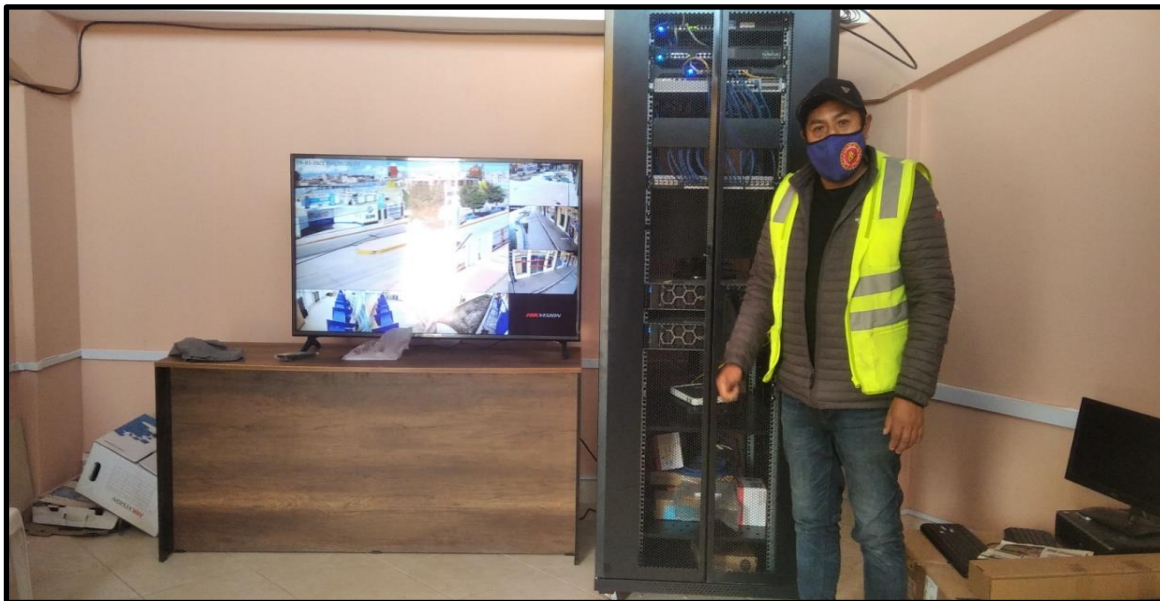
figura 4.15: instalación de cámaras video vigilancia monitorio
