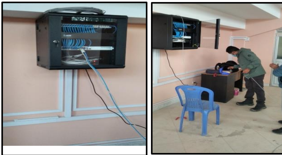
Figura 4.22: instalación de gabinete de zona C
