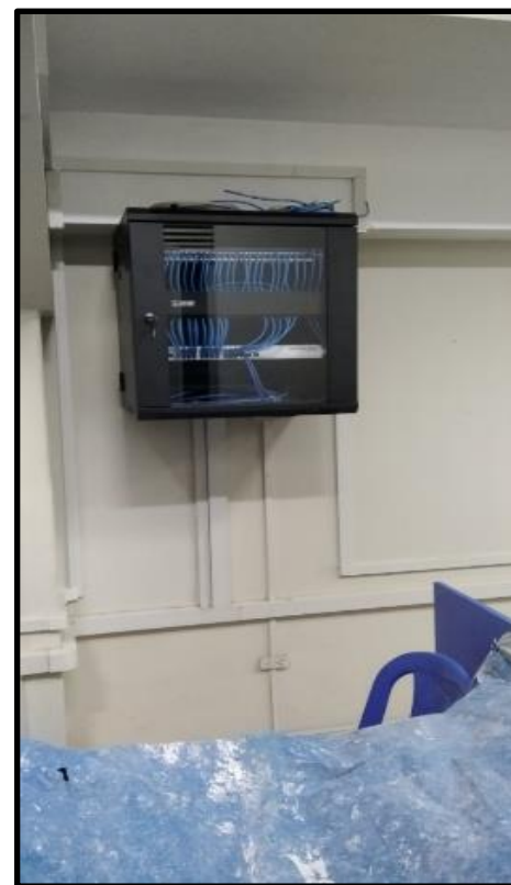
figura 4.19: Instalación de gabinetes de 12RU zona B
