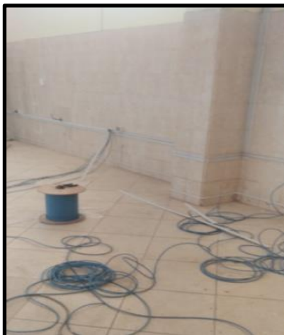
Figura 4.1: instalación de canaletas
