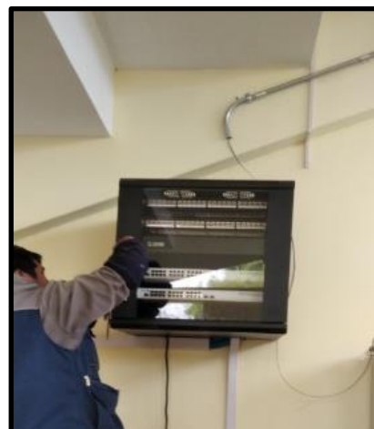
figura 4.25: Instalación de gabinete de 12RU Zona D
