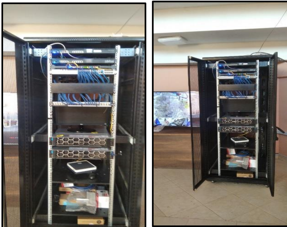
figura 4.13: instalación gabinete zona A
