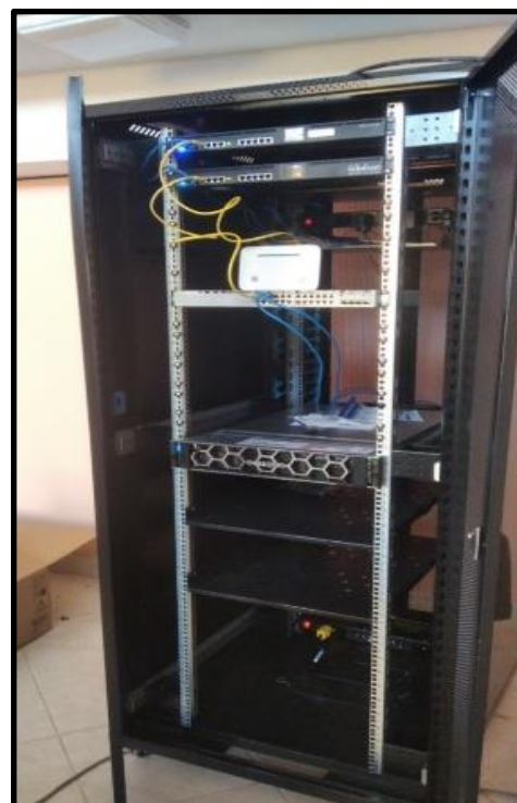
figura 4.6: instalación mikrotic balanceador
