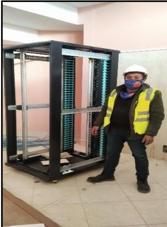
figura 4.5: Armado de gabinetes sus accesorios
