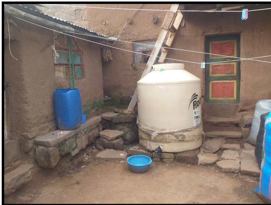
Fotografía N° 04. (Tanque de agua con conexión directa a la canaleta de agua pluvial, la cual es usada cuando no abastece el ojo de agua).
