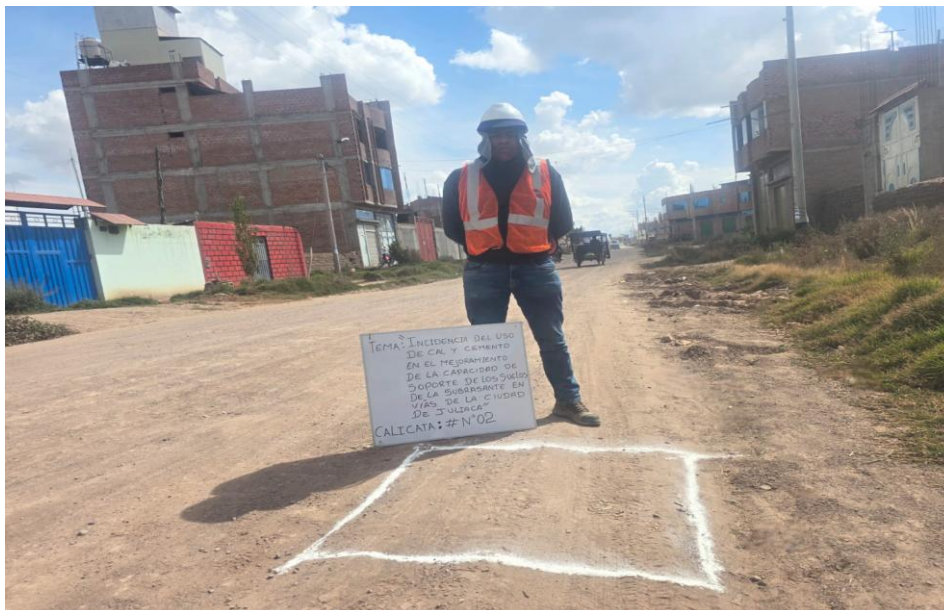
Trazo de la calicata C – 2
