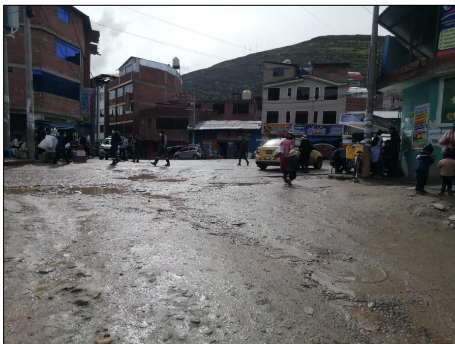
Figura 19. Fallas por erosión y lodazales en la superficie
