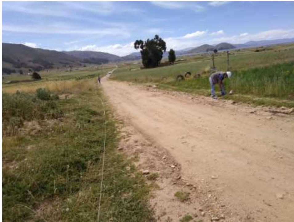
Fotografía 5. Pintado de progresivas a cada 100 metros.
