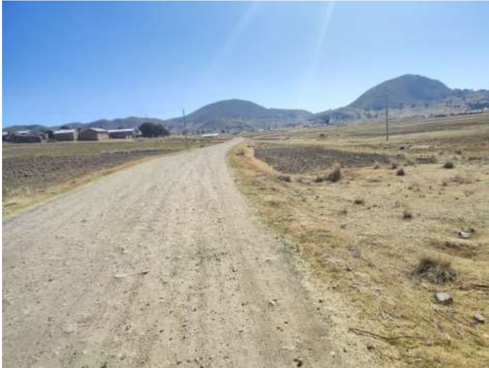
Fotografía 1. Inicio de la vía Balsarumi, progresiva 0+000.
