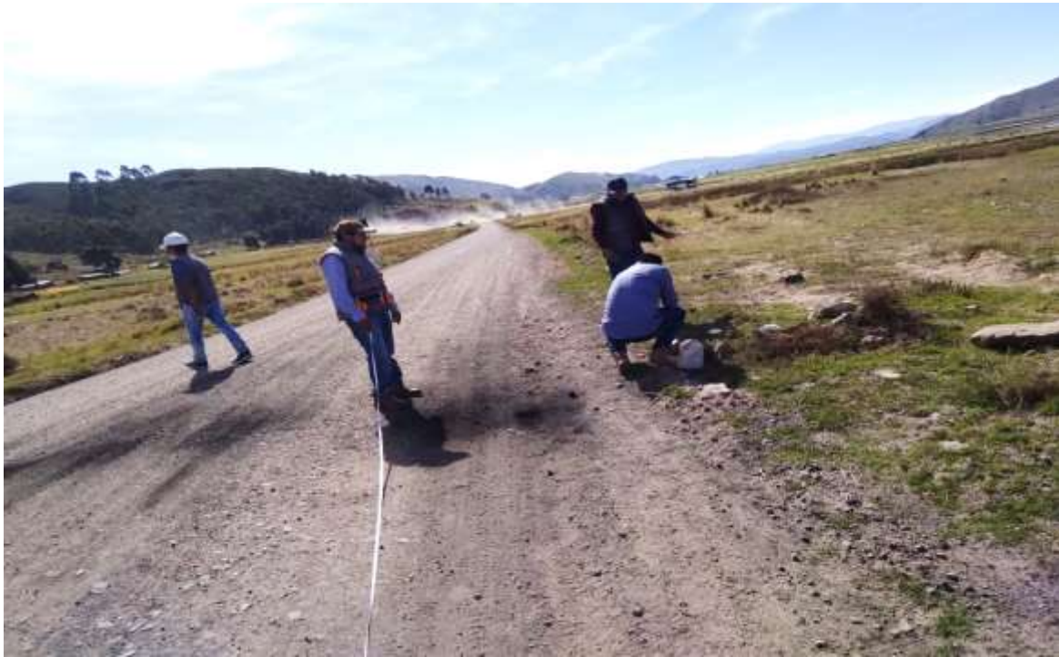
Fotografía 3. Estableciendo progresivas y recolección de datos de la vía.
