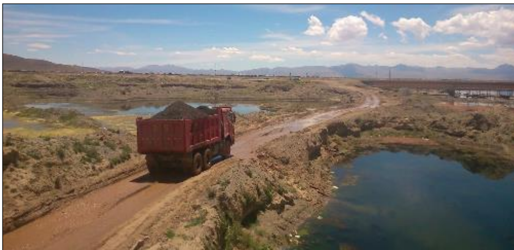
Fotografía 4. Camión volquete transportando material de agregado de la cantera Isla.
