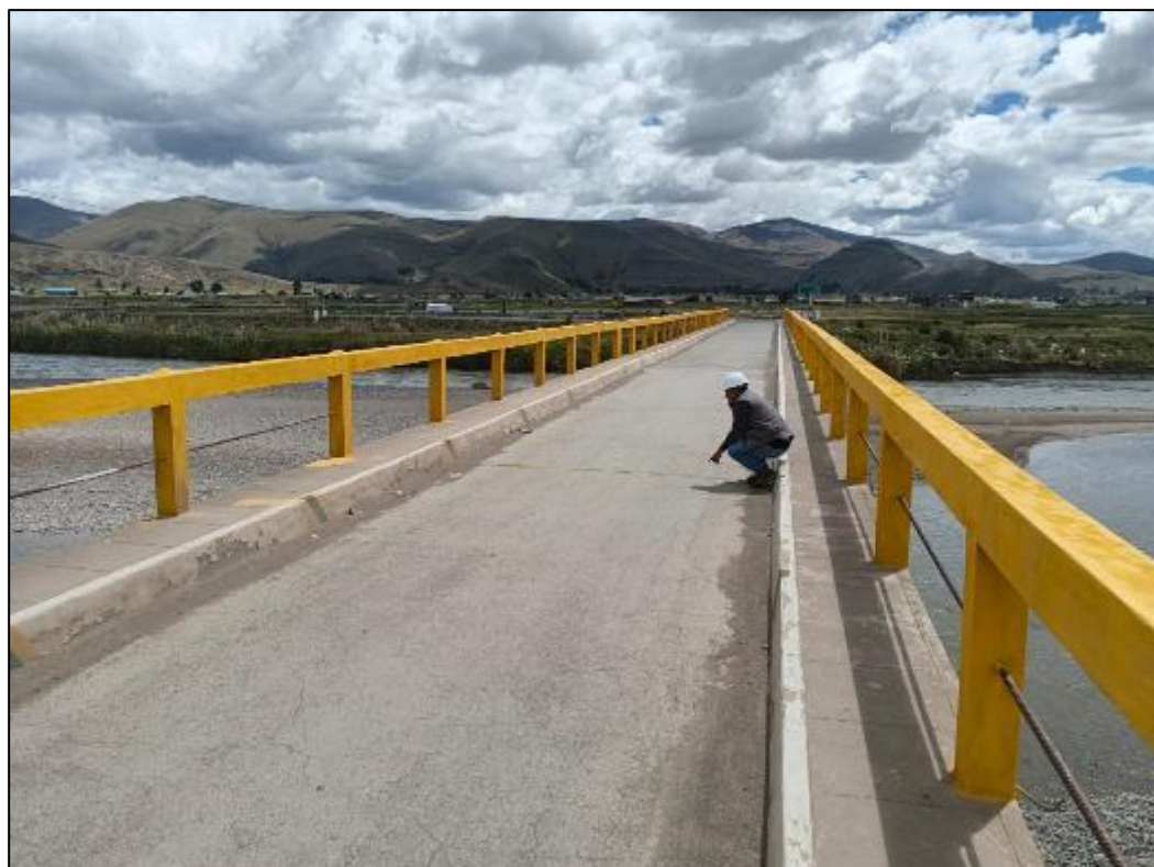
Fotografía 18. Estado de conservación de la superficie de la calzada del puente.
