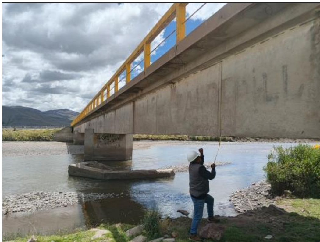
Fotografía 12. Realizando la medición del peralte de la viga de la superestructura.
