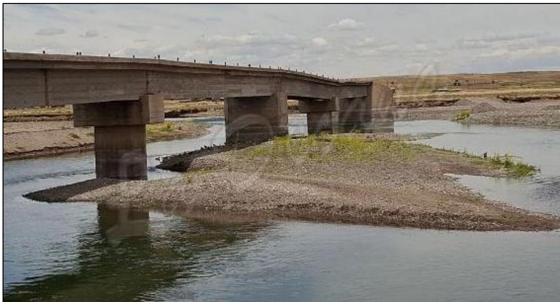
Fotografía 1. Imagen del puente Cabanillas antes de su mantenimiento.
