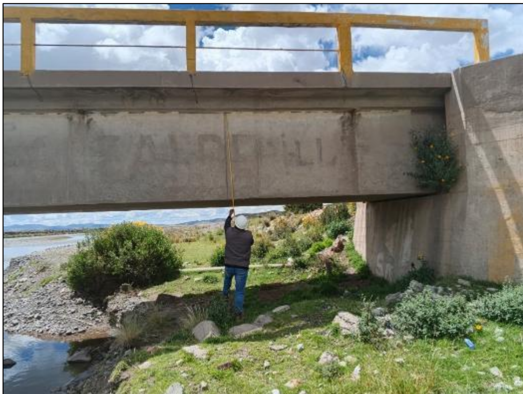
Fotografía 11. Verificación de la altura del peralte de la viga del puente.
