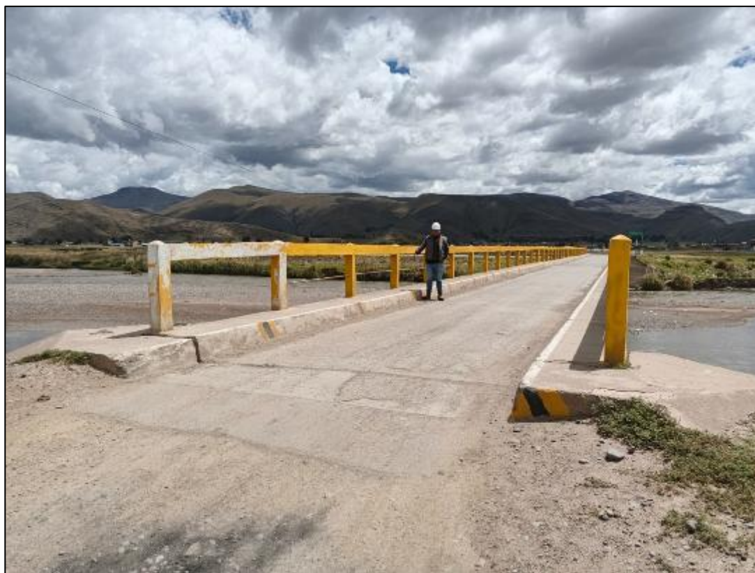
Fotografía 16. Imagen de la sección transversal del puente Cabanillas.
