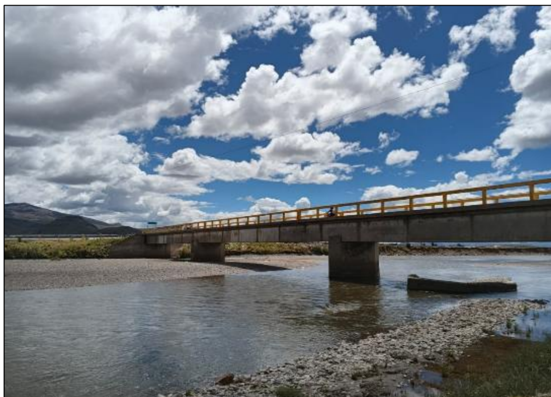
Fotografía 4. Imagen de la luz libre en un tramo del puente Cabanillas.
