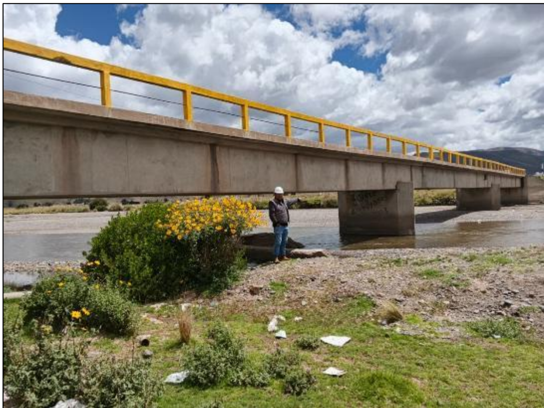
Fotografía 3. Vista de la sección de los pilares del puente.
