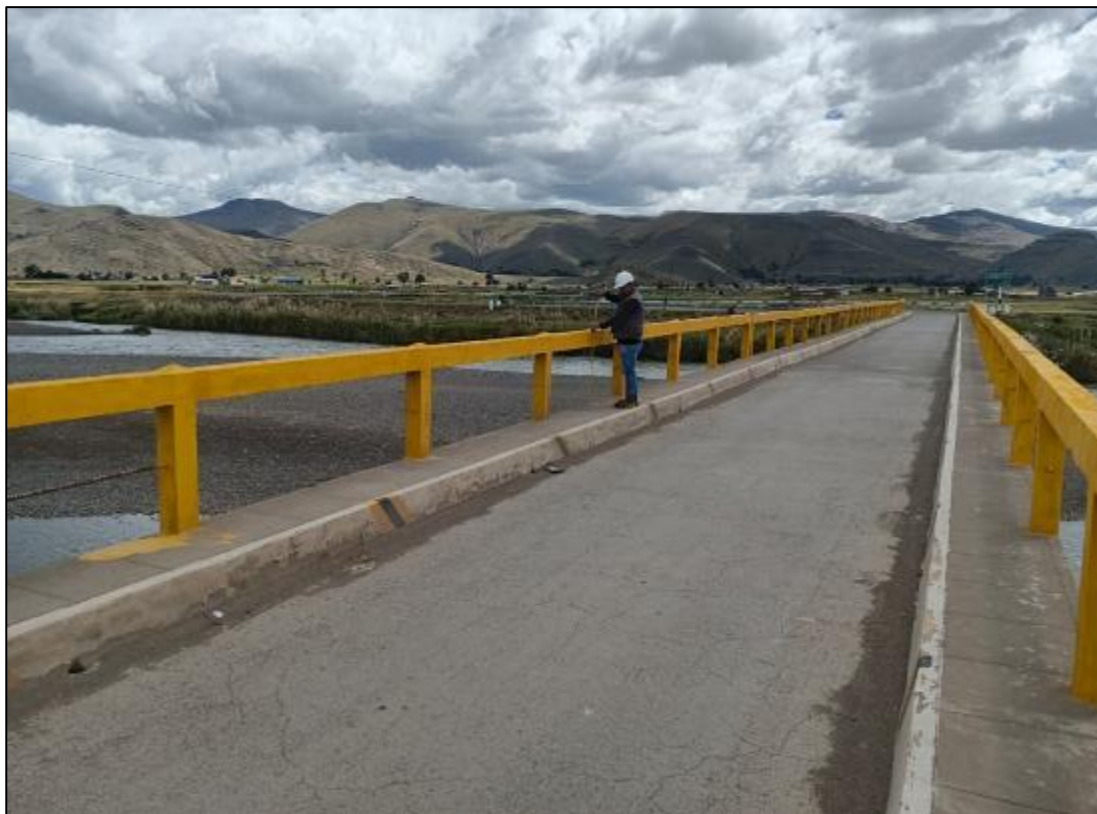
Fotografía 9. Verificación del estado de conservación de las barandas de seguridad.
