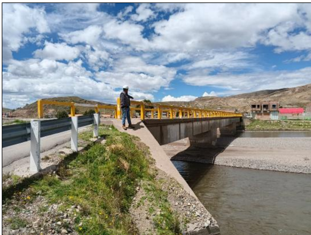
Fotografía 6. Barandas de seguridad del puente Cabanillas.
