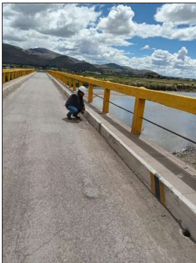
Fotografía 10. Verificación del espesor de la vereda.
