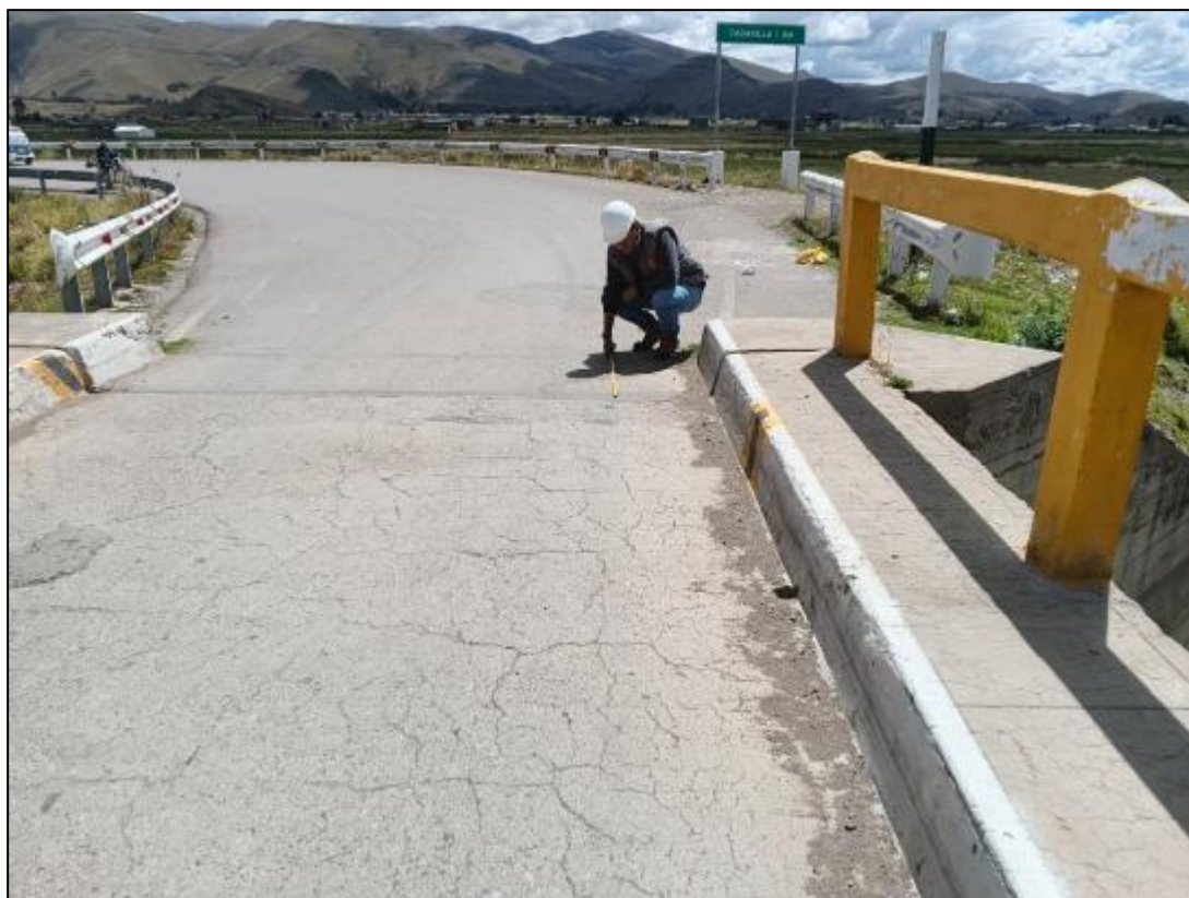
Fotografía 5. Sección de inicio de la estructura del puente.
