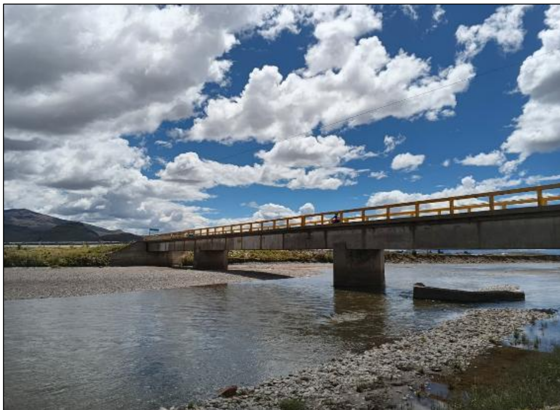
Fotografía 2. Vista del puente Cabanillas.
