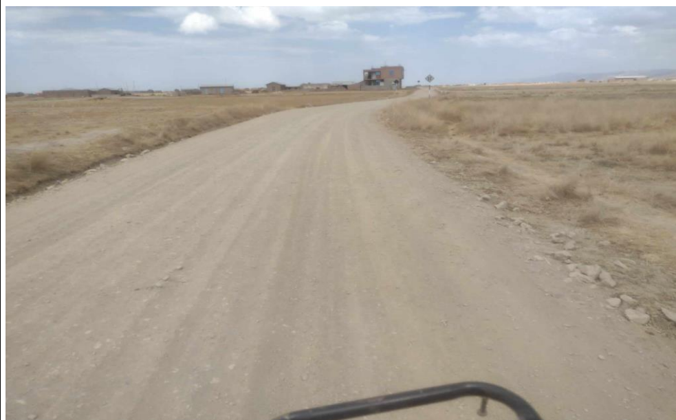
FOTO N° 14: La progresiva 1+750 necesita el desmonte de la vegetación.
