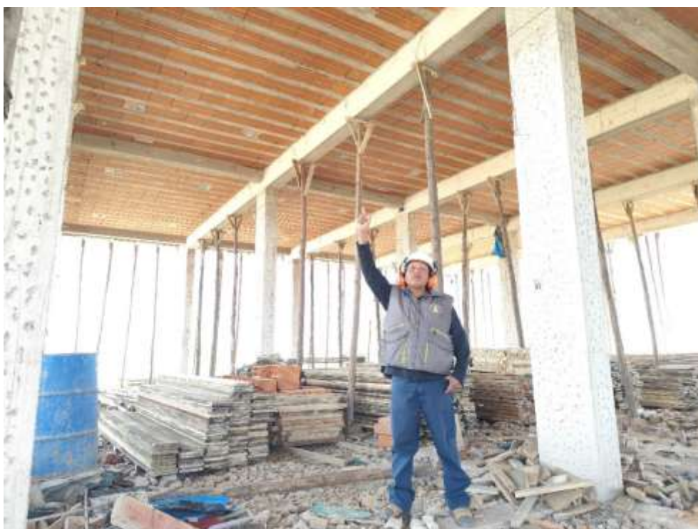
Fotografía 4. Desencofrado de Losa tradicional
