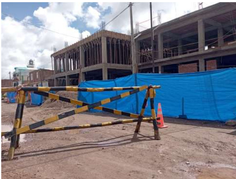
Fotografía 2. Vaciado de losas pretensadas
