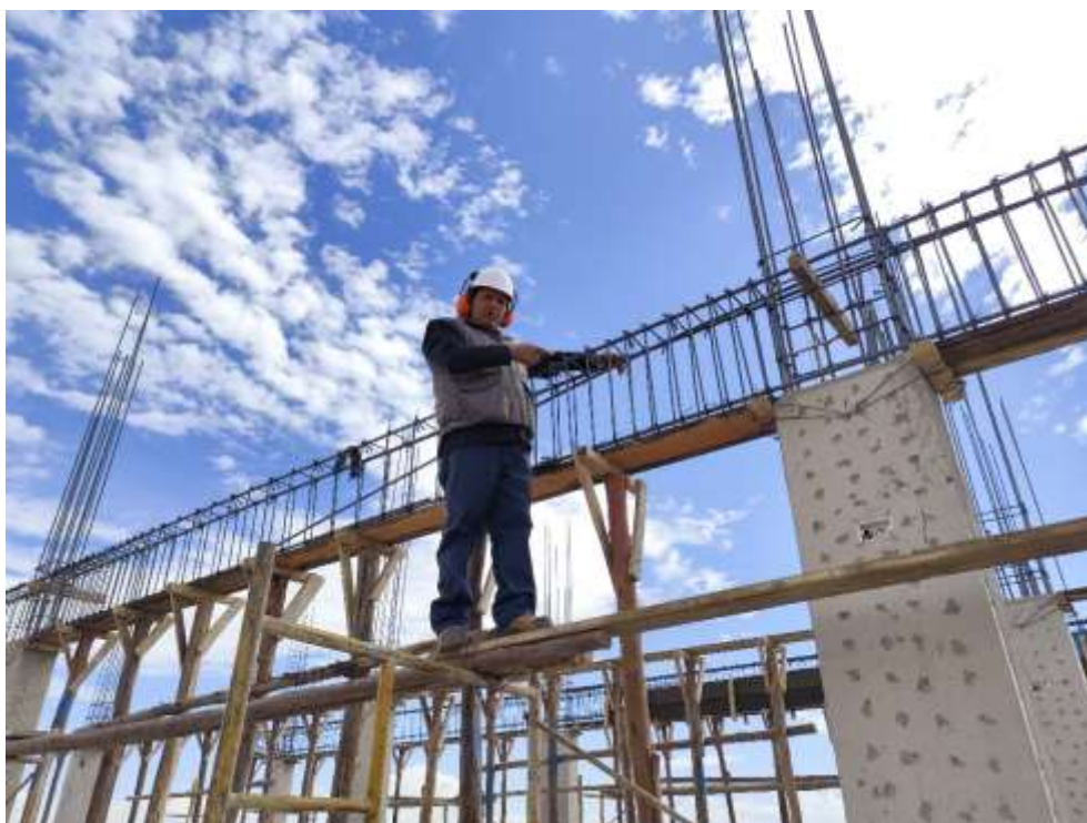
Fotografía 6. Encofrado de vigas para colocación de losas pretensadas
