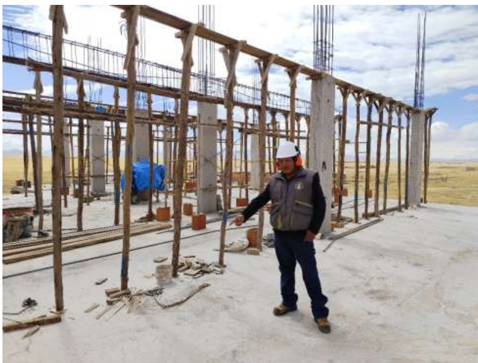
Fotografía 5. Encofrado de vigas para posterior armado de losas pretensadas
