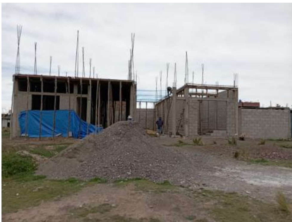
Fotografía 1. Encofrado de vigas y losas aligeradas
