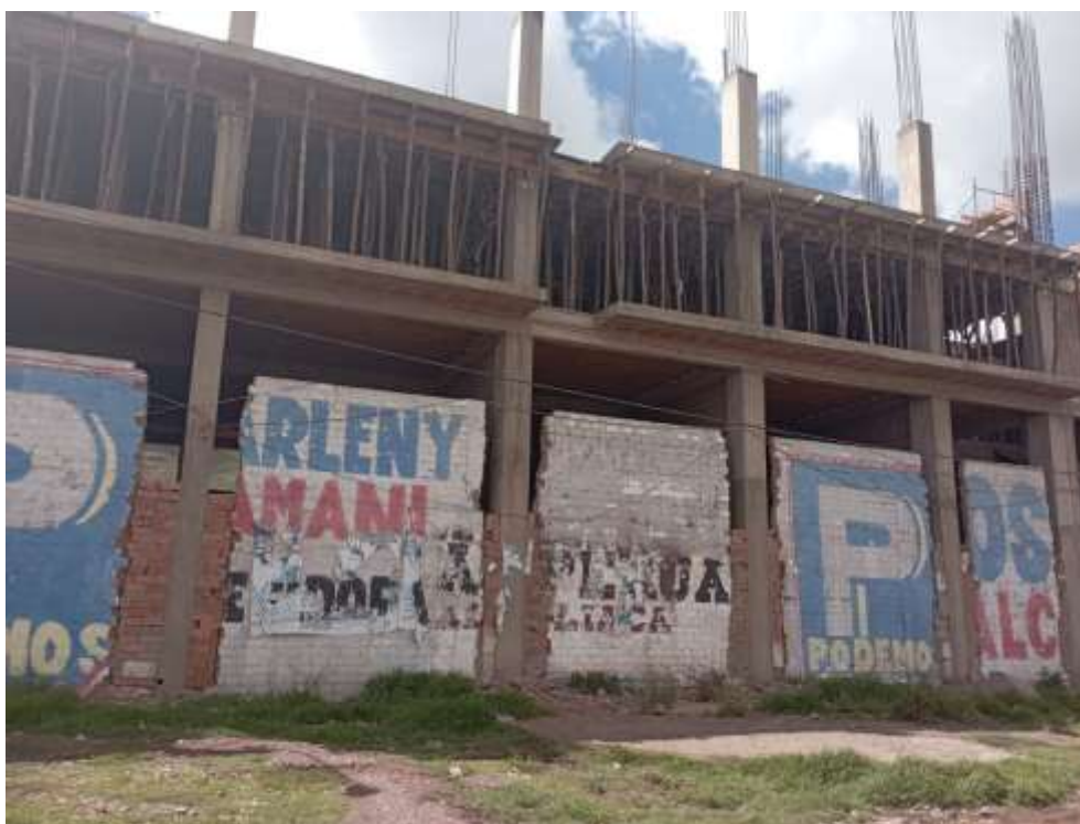
Fotografía 3. Vaciado de Losa tradicional
