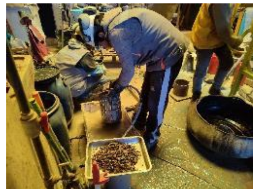
Fotografía 6. Ensayo Columna de Segregación-Lavado y separación de los agregados con el tamiz N°4.
