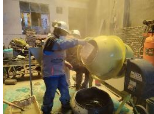
Fotografía 8. Adición de materiales a la mezcladora.
