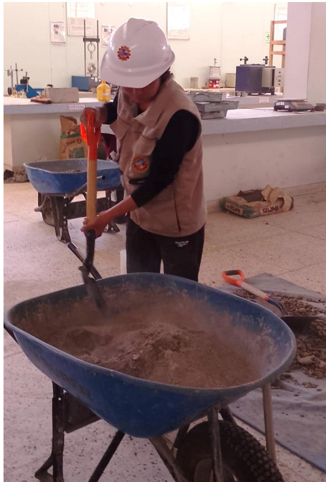
Fotografía 8. Mezcla de concreto hidráulico
