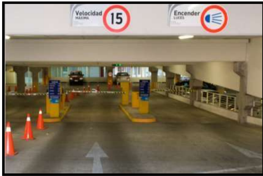
Figura 8. Estacionamiento subterráneo - Chile
