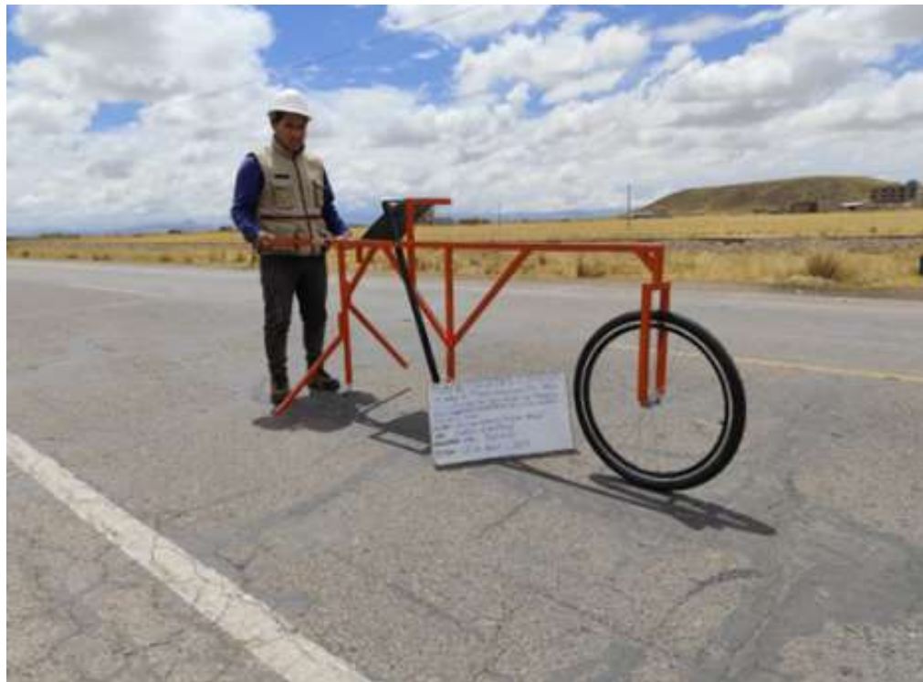
Fotografía 8. Rugosidad en el tramo 5 +000 km
