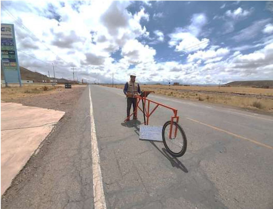
Fotografía 5. Evaluación de del estado de pavimento en el lado izquierdo
