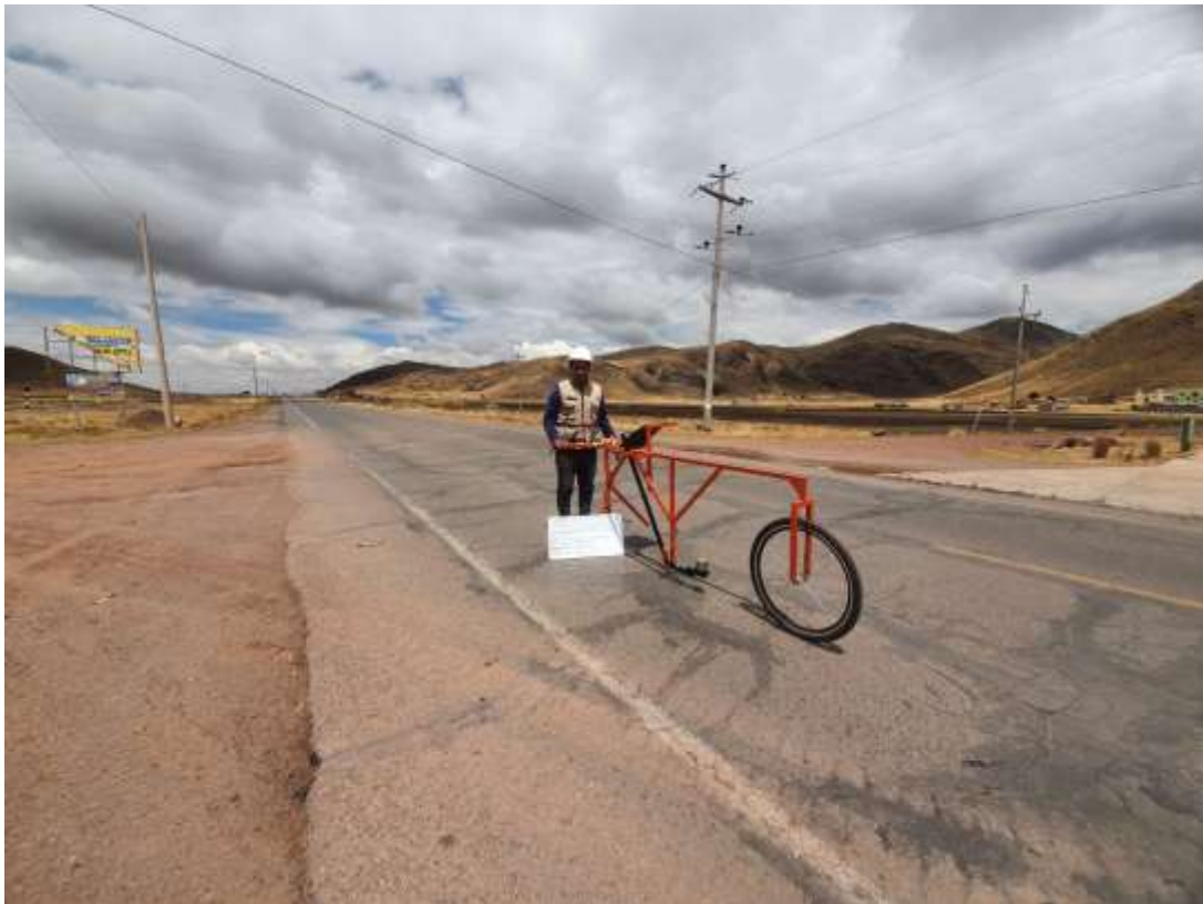
Fotografía 3. Rugosidad en el tramo 4 +800 km carril derecho
