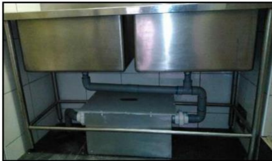
Figura 3: Interceptor de grasa hidromecánico en posición relativa..
