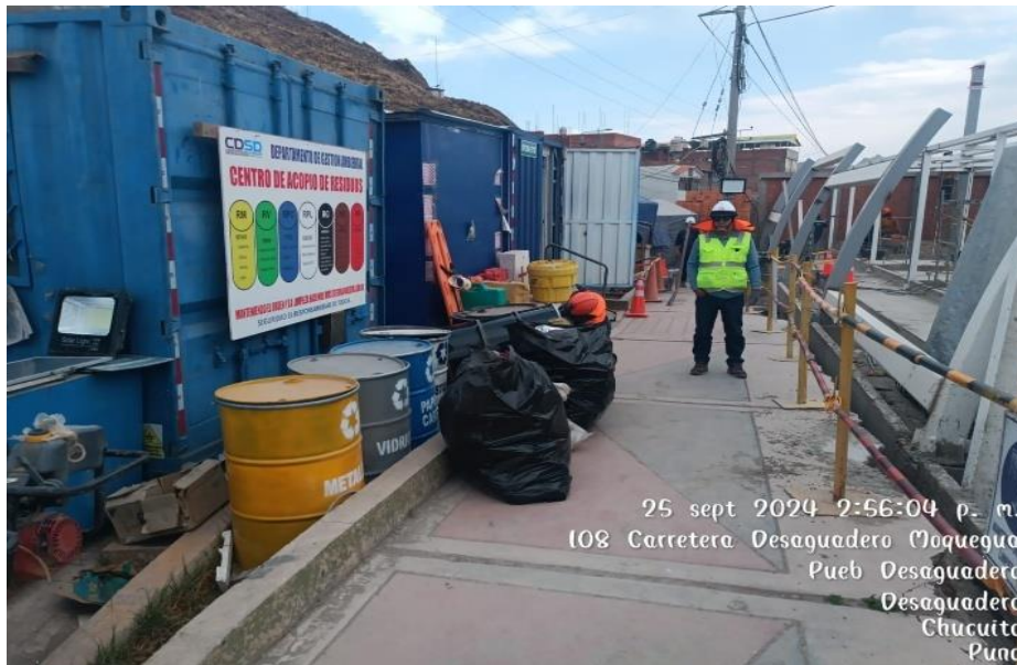
Fotografía 01: Ubicación de centro de acopio de residuos en Desaguadero.
