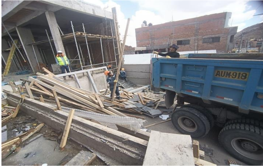
Fotografía 03: traslado de encofrados de madera en obra
