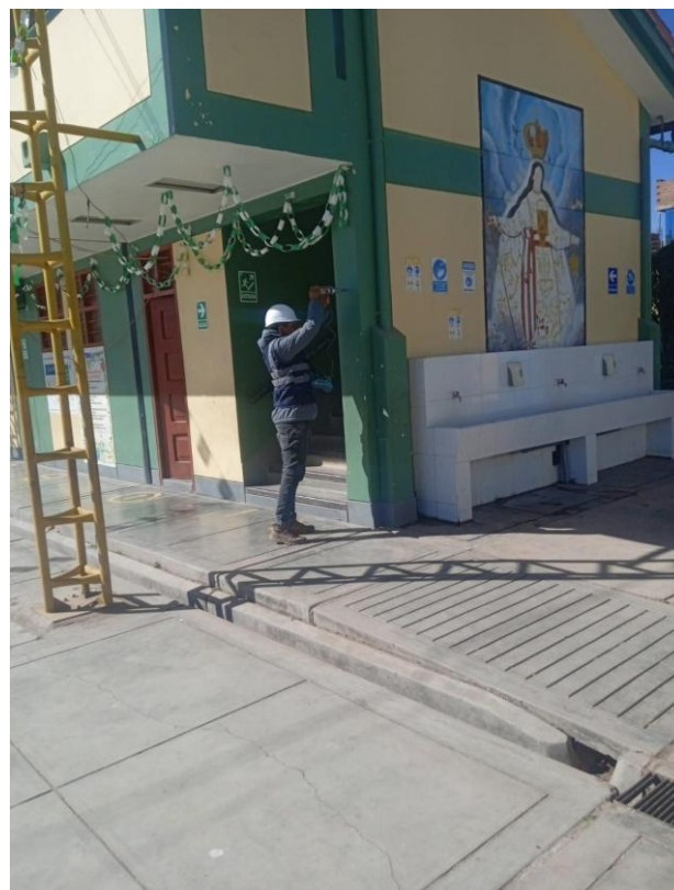
Fotografía 2. Vista fotográfica sobre la elaboración de ensayo de esclerómetro en columna.
