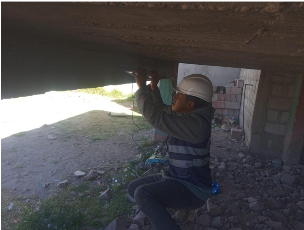
Fotografía 8. Vista fotográfica sobre la elaboración de ensayo de esclerómetro en la viga.
