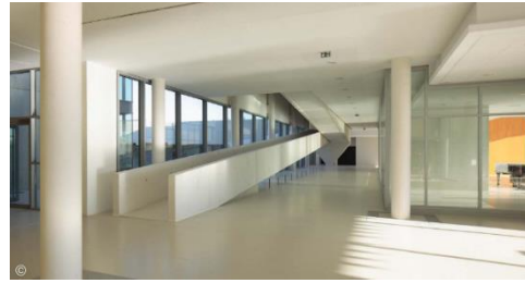
Figura 21: Pilares, Rampas De La Escuela
