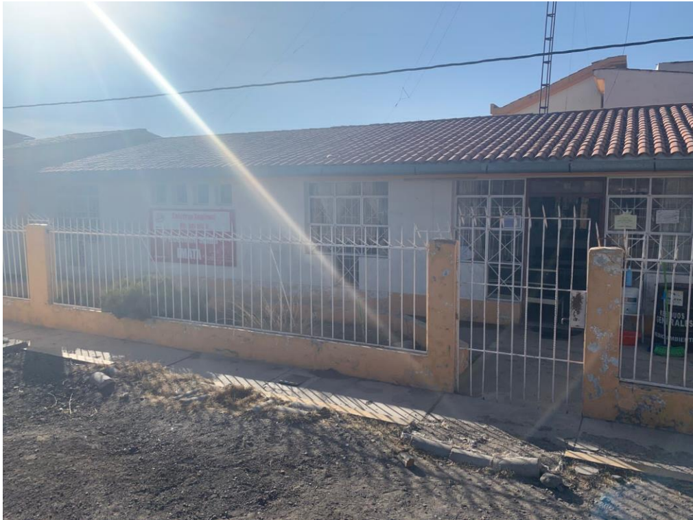
FACHADA DEL PUESTO DE SALUD IMATA
