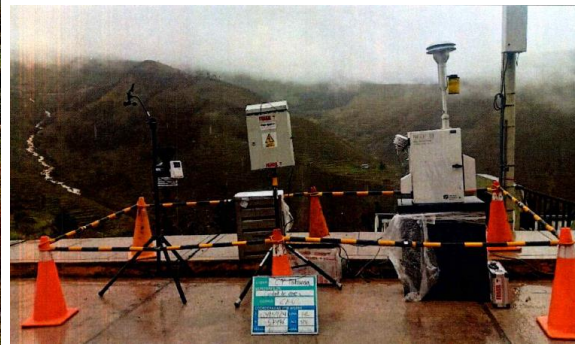
Fotografía N o 24: 3ra Estación de Calidad de Aire (CA-02) – Mejoramiento
