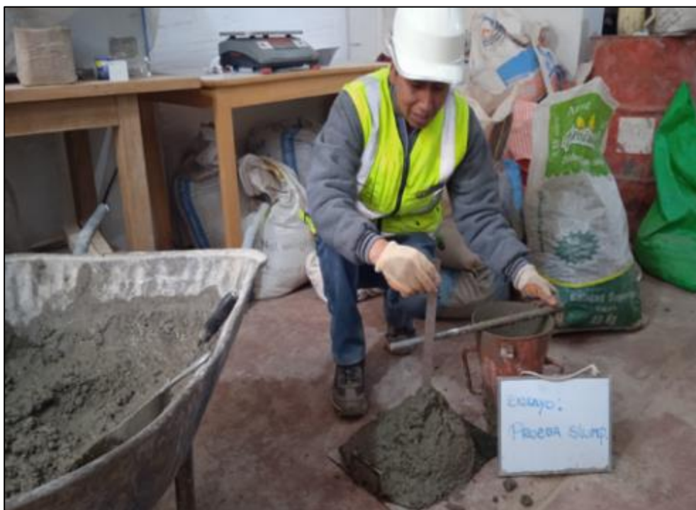
Fotografía 21. Prueba de revenimiento o Slump
