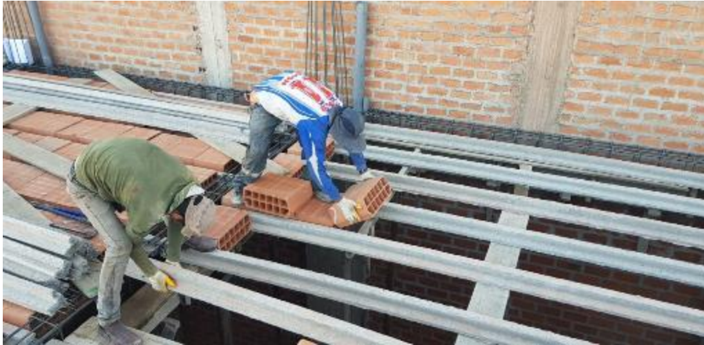
Fotografía 15: Visita a obra para recolección de datos habilitado de bovedillas de arcilla sobre viguetas pretensadas proyecto vivienda familiar
