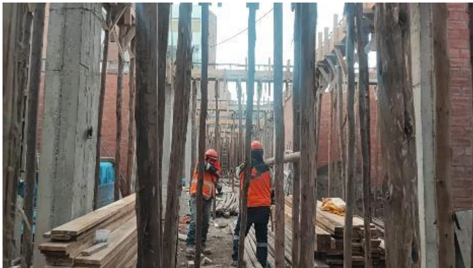
Fotografía 2: Visita a obra para recolección de información. apuntalado, fondo de vigas y tapas laterales en viga. proyecto galerías y departamentos jr. Ricardo Palma cercado Puno
