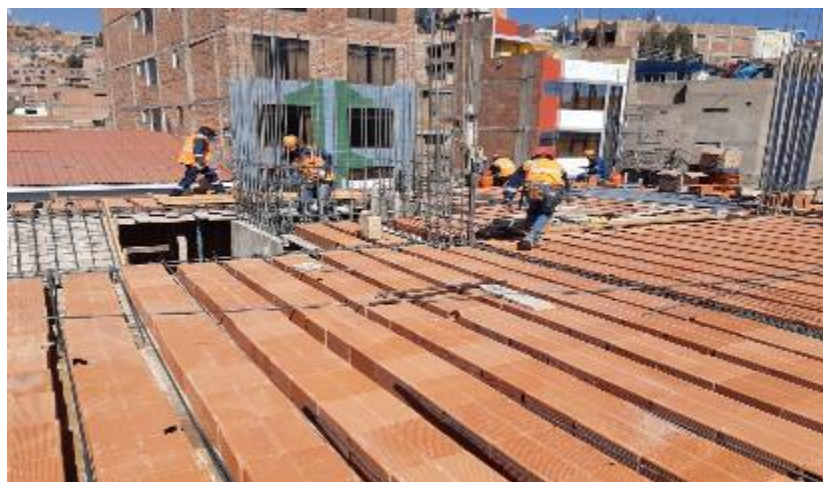
Fotografía 7: Visita a obra para recolección de información habilitado de ladrillo de 30x30x15 cm en losa aligerada. Proyecto galerías y departamentos.
