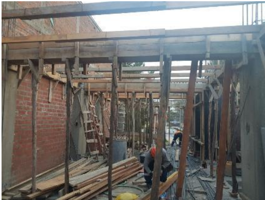
Fotografía 13: Visita a obra para recolección de datos partida solereado en losa aligerada proyecto departamentos
