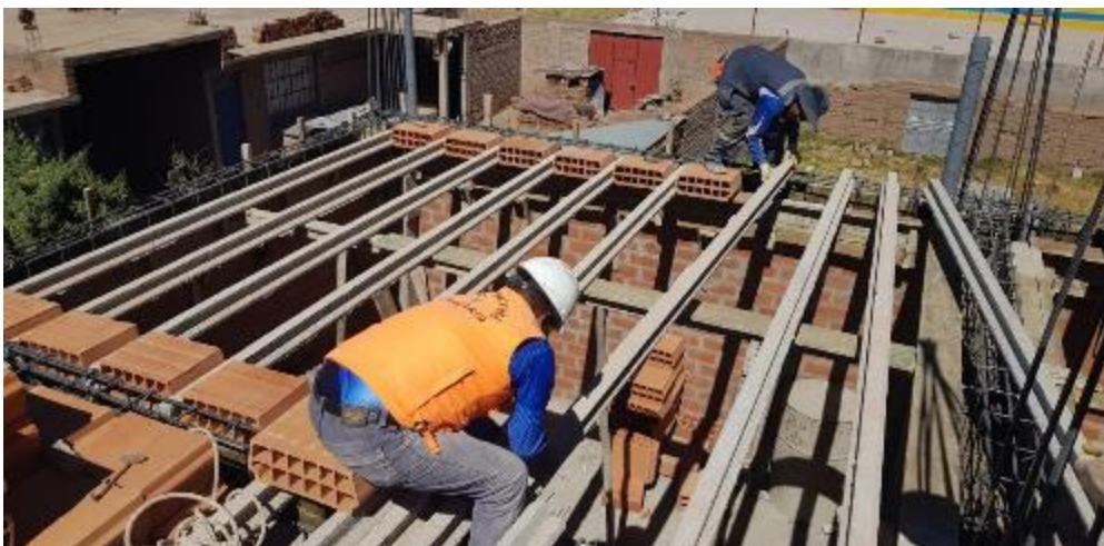
Fotografía 14: Visita a obra para recolección de datos alineamiento y distribución de viguetas a cada 50 cm proyecto vivienda familiar.
