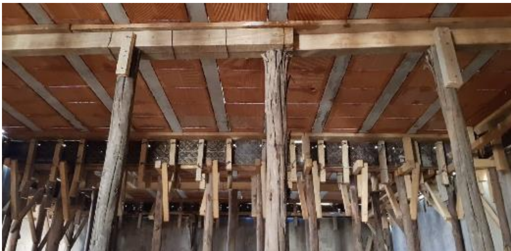
Fotografía 16: Visita a obra para recolección de información vista interior losa aligerada bovedillas de arcilla y viguetas pretensadas proyecto vivienda familiar.
