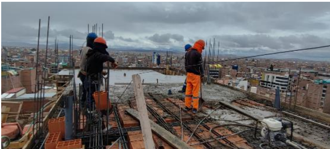
Fotografía 11: Visita a obra para recolección de información concreto premezclado in situ. Vertido de concreto en losa aligerada proyecto tiendas y departamentos.
