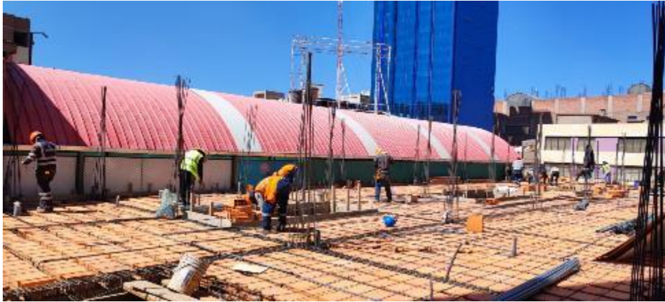
Fotografía 10: Visita a obra para recolección de información partida tendido de temperatura en losa aligerada proyecto galerías.
