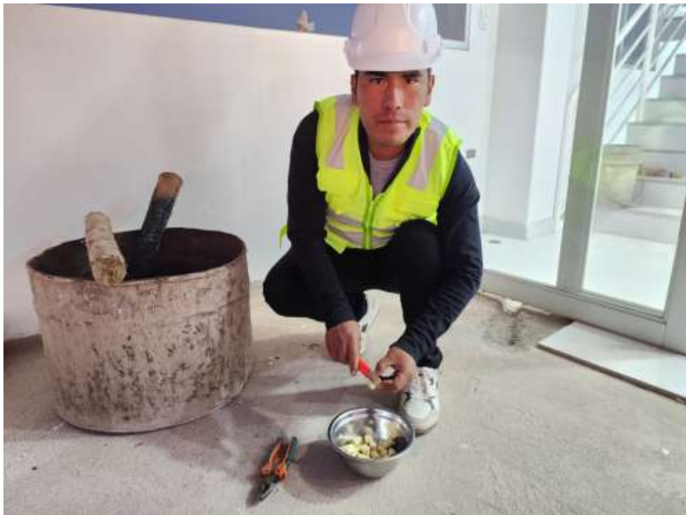
Fotografía 2. Triturado y cortes de los corchos reciclados
