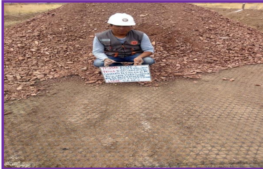
Fotografía N° 03: Colocación del geotextil en la subestructura de experimento
