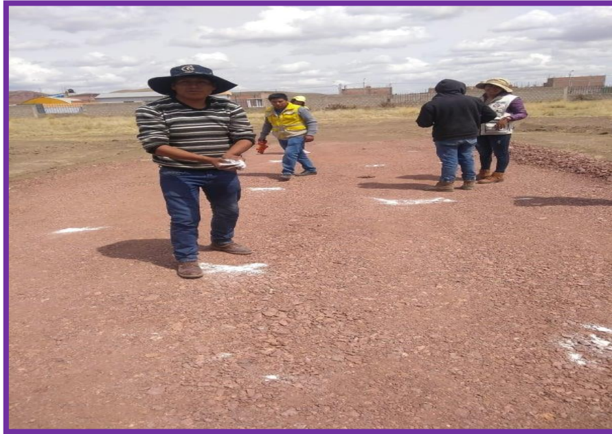
Fotografía N°09: Marcado para realizar en estos puntos el ensayo de viga Benkelman
