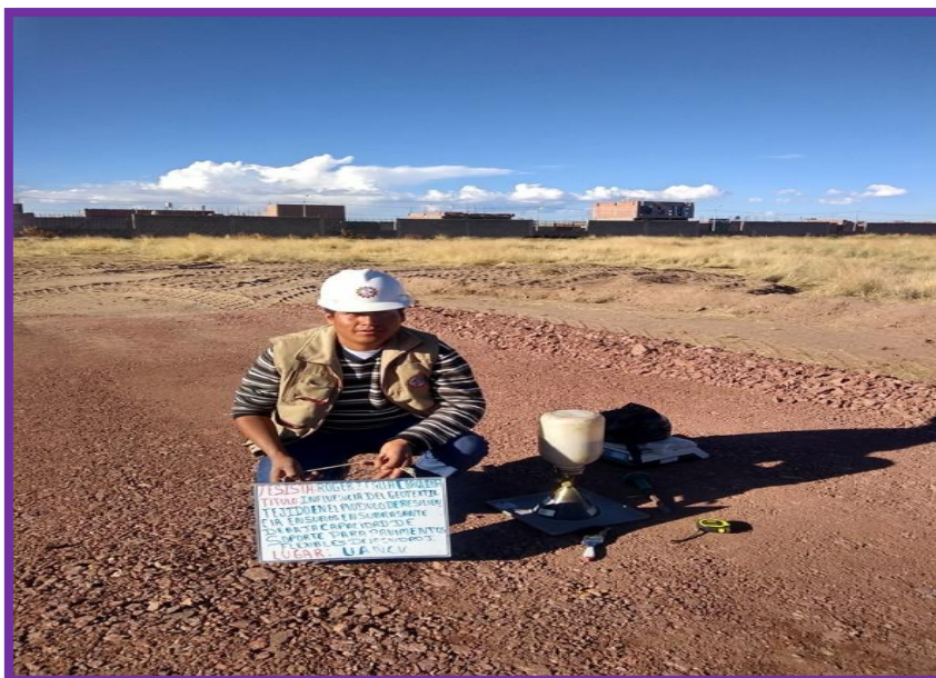
Fotografía N° 08: Ensayo de densidad de campo en las subestructuras
