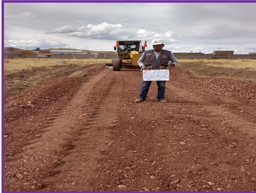
Fotografía N° 05: Extendido del material de relleno de la cantera Taparachi
