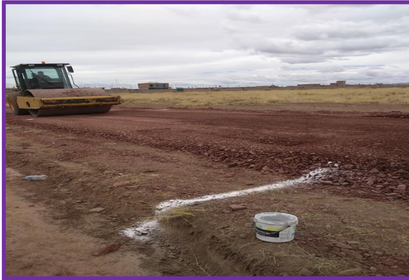
Fotografía N° 07: Compactación de las subestructuras
