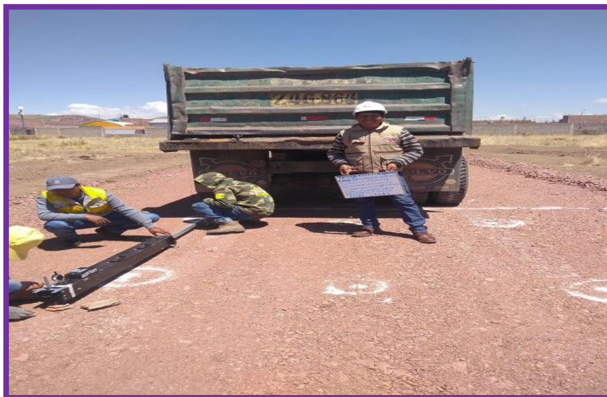
Fotografía N°10: Ensayo de viga Benkelman
