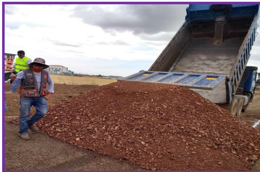
Fotografía N°04: Conformación de la subestructura con geotextil de experimento con Material de la cantera Taparachi
