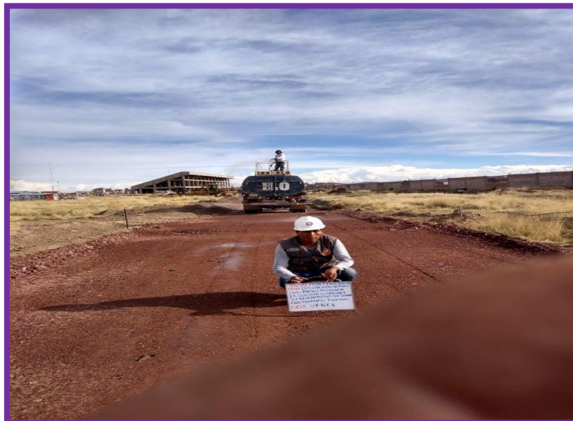
Fotografía N° 06: Saturación con agua de las subestructuras
