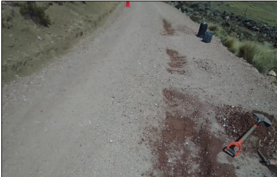
Fotografía 1. Inicio del tramo progresivo km 0+000
