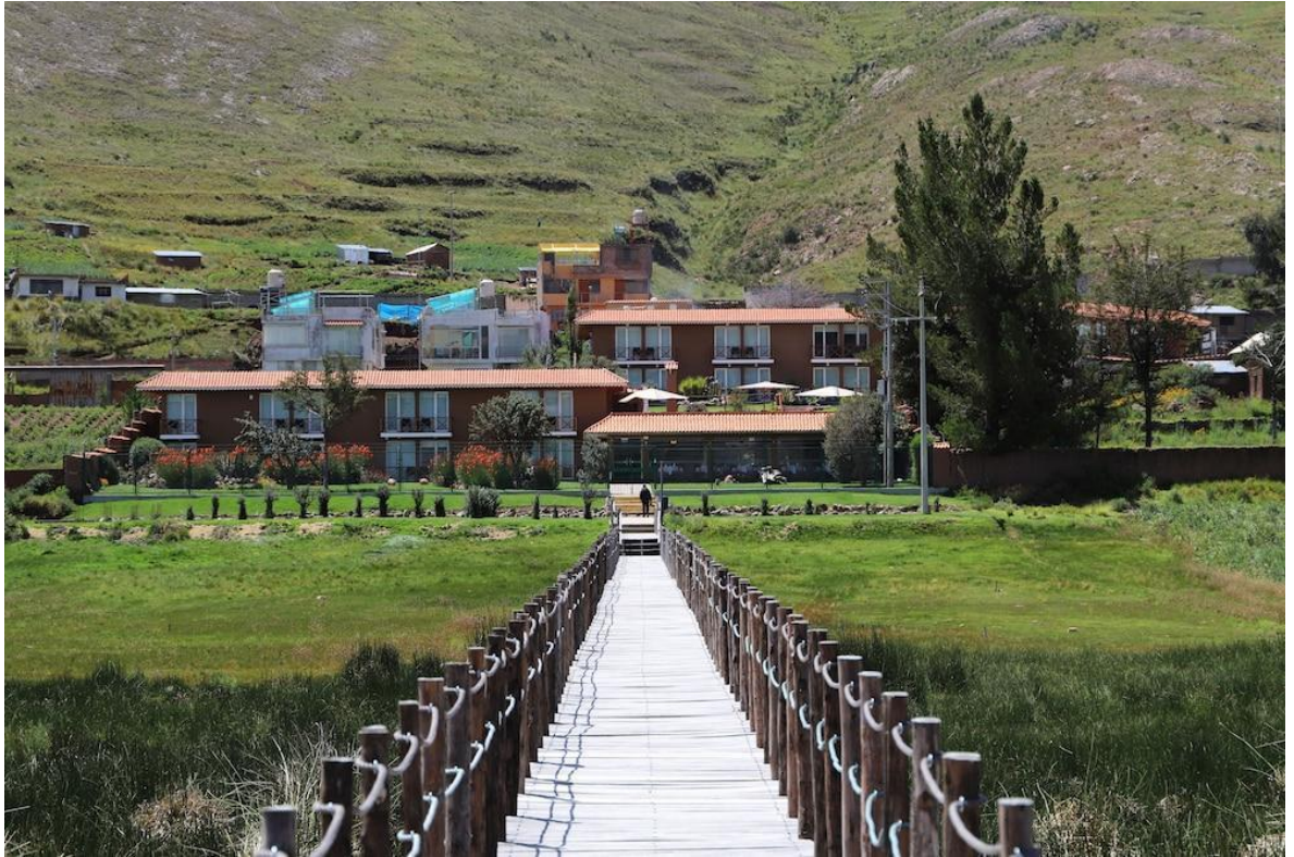
FIGURA 29 Vista del hotel Casa Andina.
