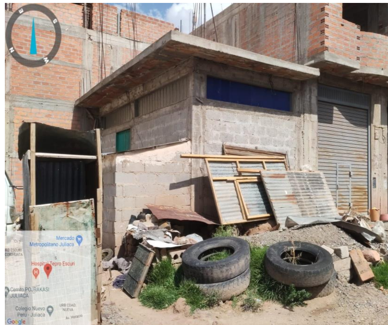
Fachada exterior de letrina L2
