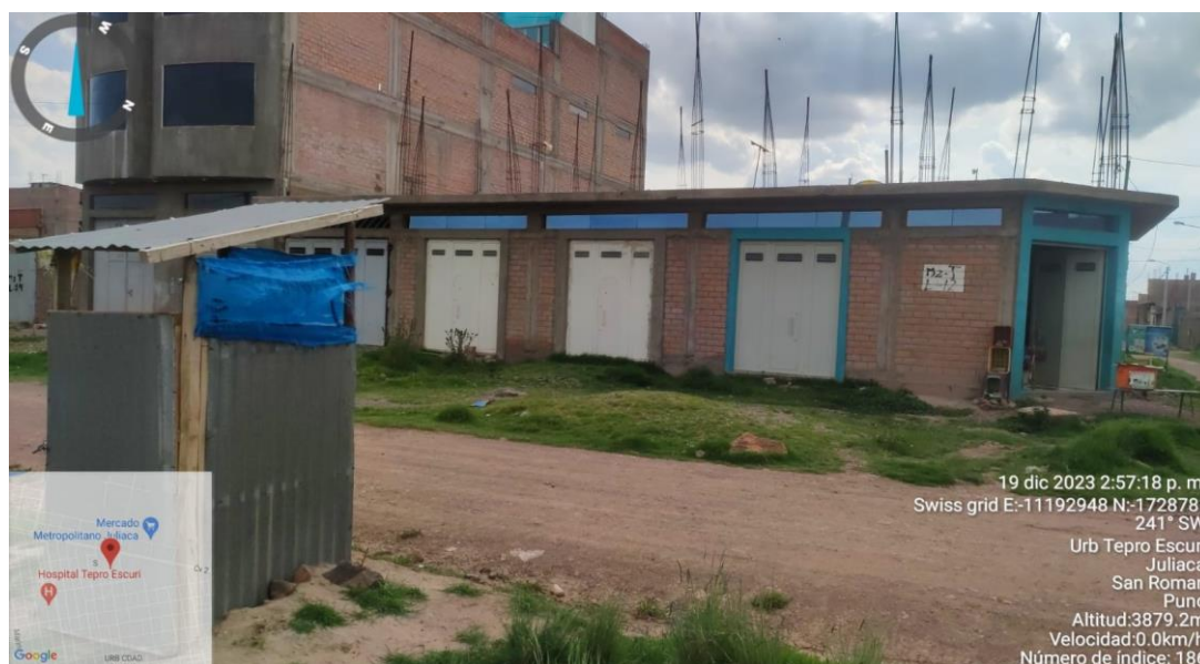
Fachada exterior de letrina L6
