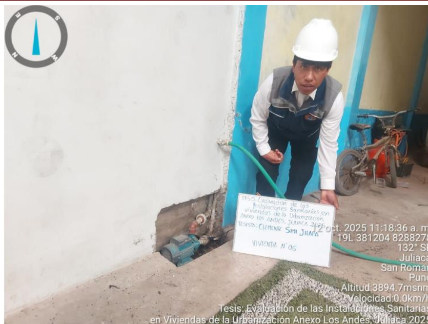
Fotografía 03: Inspección de conexión domiciliar y toma de datos en campo.
