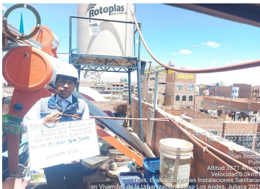
Fotografía 08: Verificación del sistema de abastecimiento con tanque elevado y conexiones visibles en azotea.
