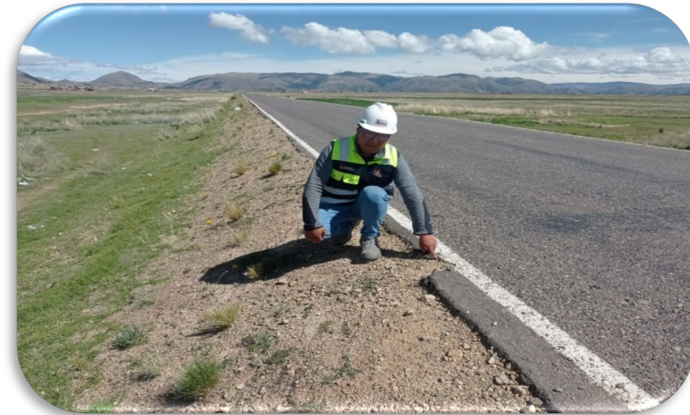
FOTOGRAFÍA 04: VÍA EXISTENTE CON SUELO - CEMENTO
