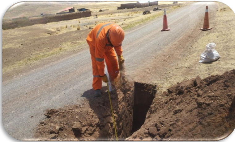
FOTOGRAFÍA 01: REALIZACIÓN DE LA CALICATA 01
