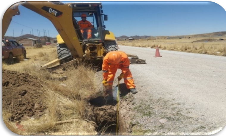
FOTOGRAFÍA 03: REALIZACIÓN DE LA CALICATA 03
