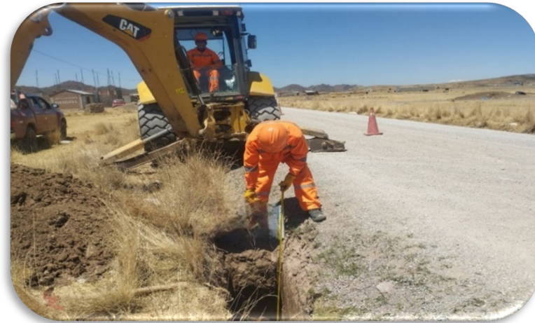
FOTOGRAFÍA 02: REALIZACIÓN DE LA CALICATA 02
