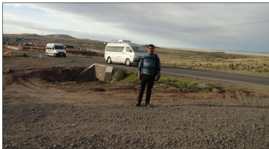
Fotografía 17. Funcionamiento actual de la vía.
