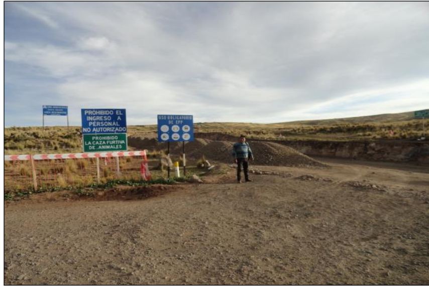
Fotografía 15. Zona de ejecución de trabajos de la autopista Juliaca – Puno.
