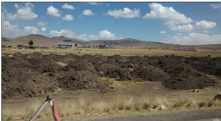
Fotografía 20. Proyección de botaderos para la eliminación de material excedente.
