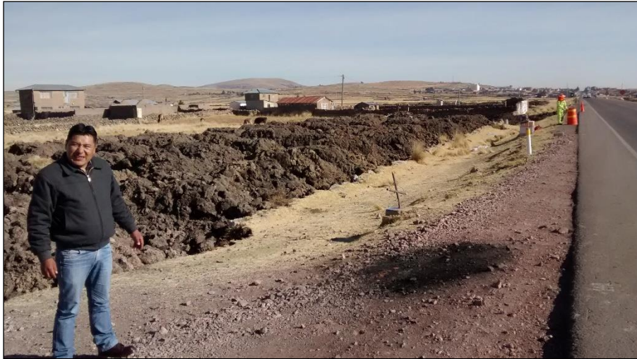
Fotografía 18. Botaderos improvisados al costado de la vía.
