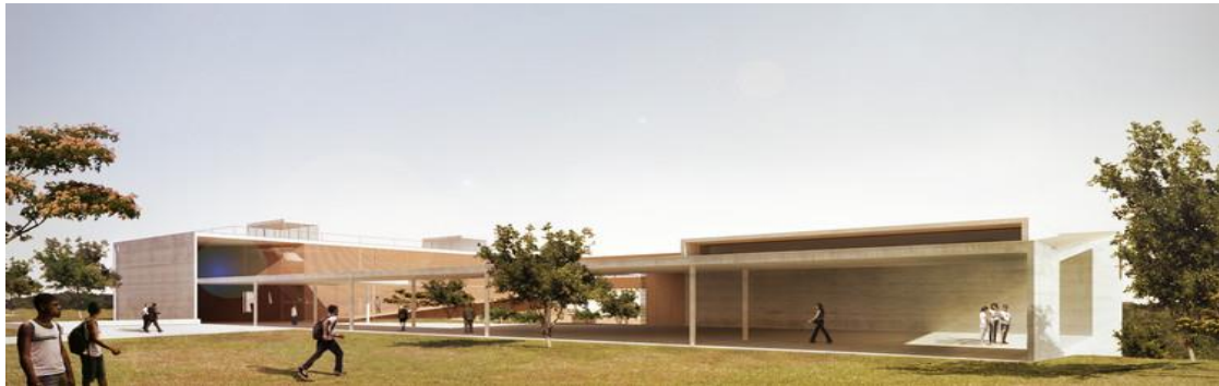
Figura 25. Vista lateral Renova Arquitectura
