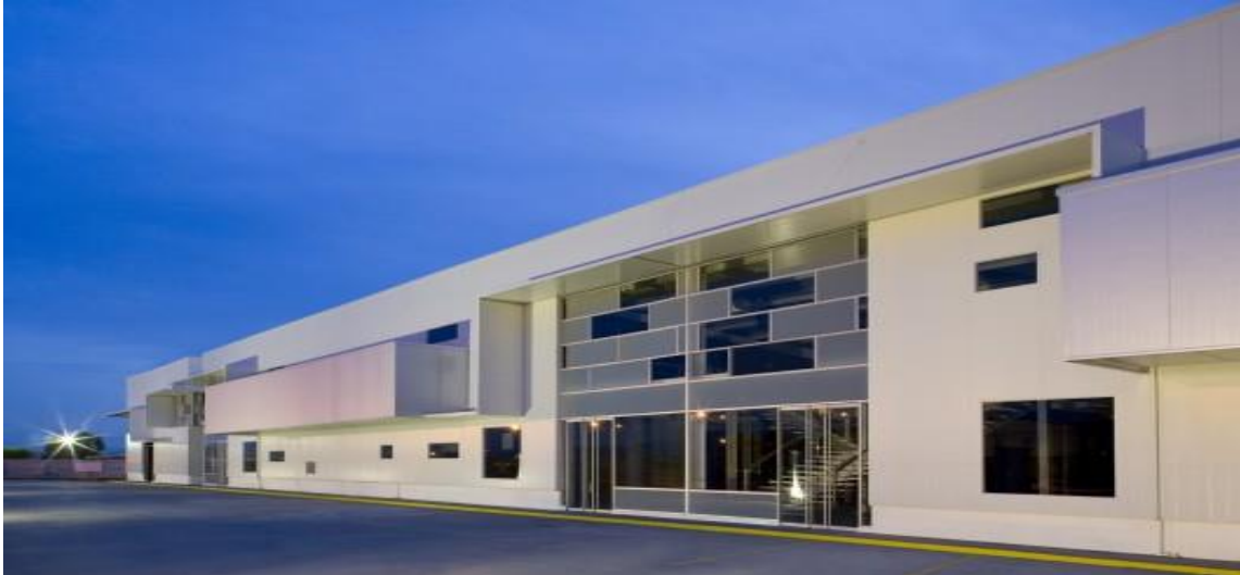
Figura 22. Fachada conjunto industrial TREX
