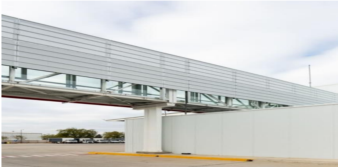
Figura 40. Puente de circulación
